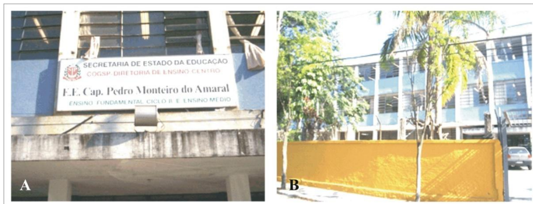
Figura 13 - Entrada principal da Escola. (A) Placa de identificação e (B) Acesso pela Rua Núrsia, no bairro Jardim São Bento [Fonte: o autor]
