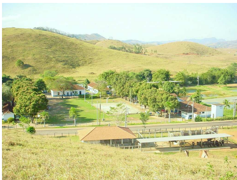
QUADRO 11 – Vista geral da área central do CTAIBB
