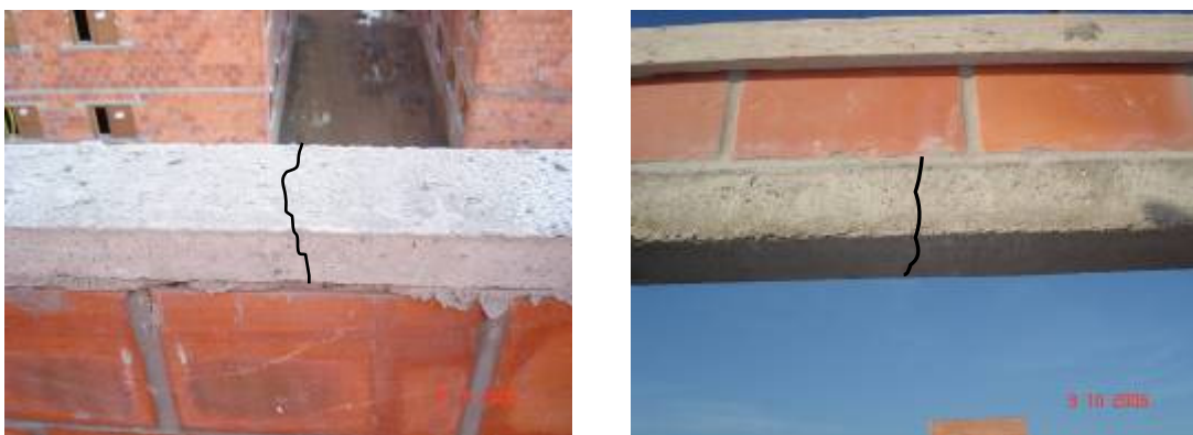
(a) contraverga pré-moldada fissurada
