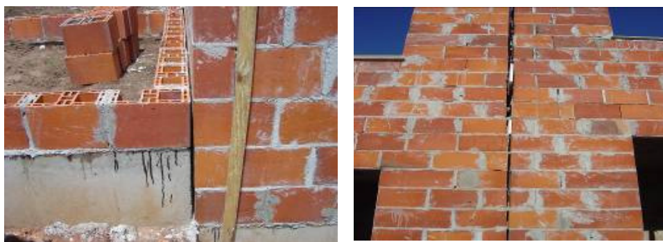
(a) junta de dilatação sem isopor no interior (b) junta de dilatação com variação na espessura e sem isopor
