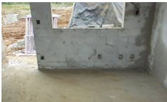
Figura 35: fissuras nas juntas de argamassa devidas à retração por secagem de blocos
