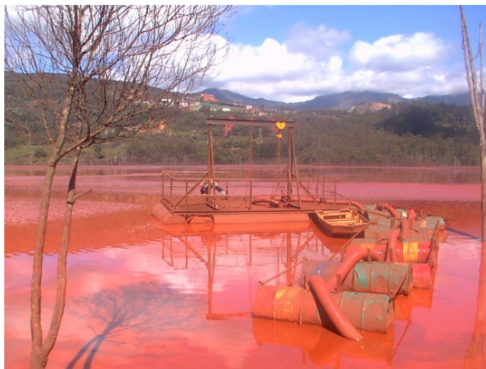
Figura 3.13: Sistema de bombeamento da lama
