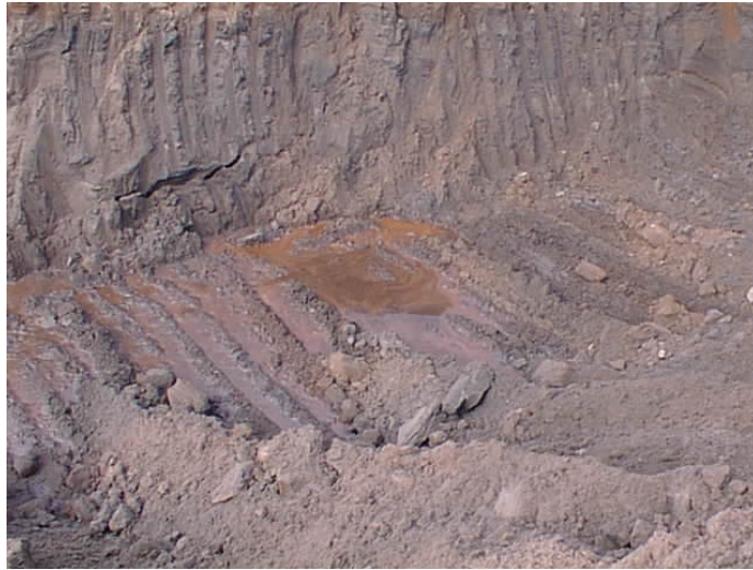
Figura 3.10: Escavação atingindo a camada de lama
