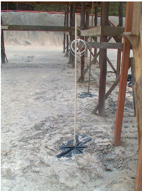
Figura 3.32: Instalação do tensiômetro na base de areia
