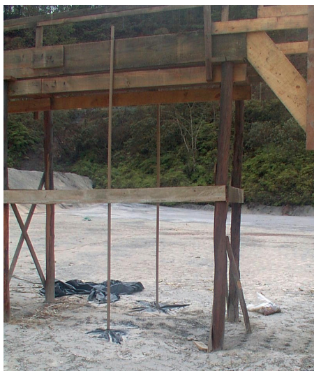
Figura 3.30: Vista dos dois piezômetros instalados
