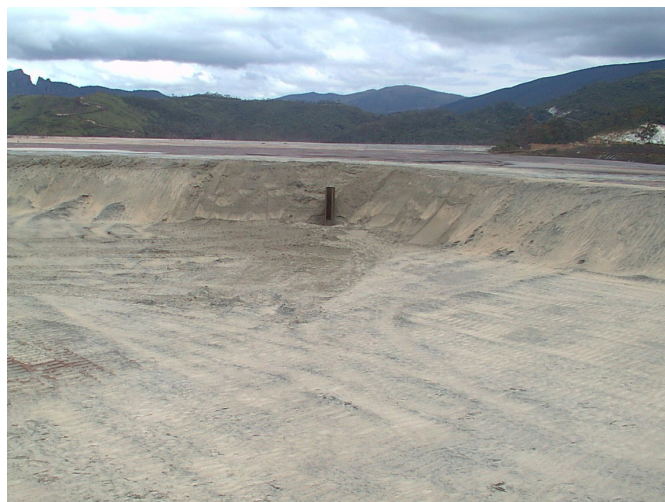
Figura 3.12: Vista do vertedouro
