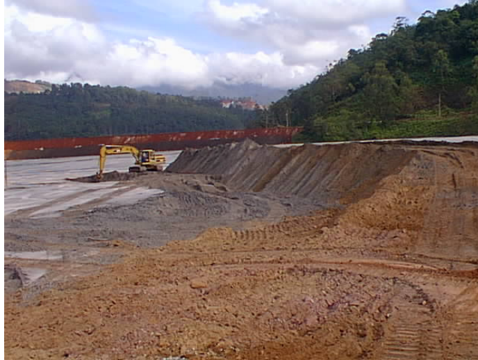
Figura 3.11: Construção do dique que limita a área teste
