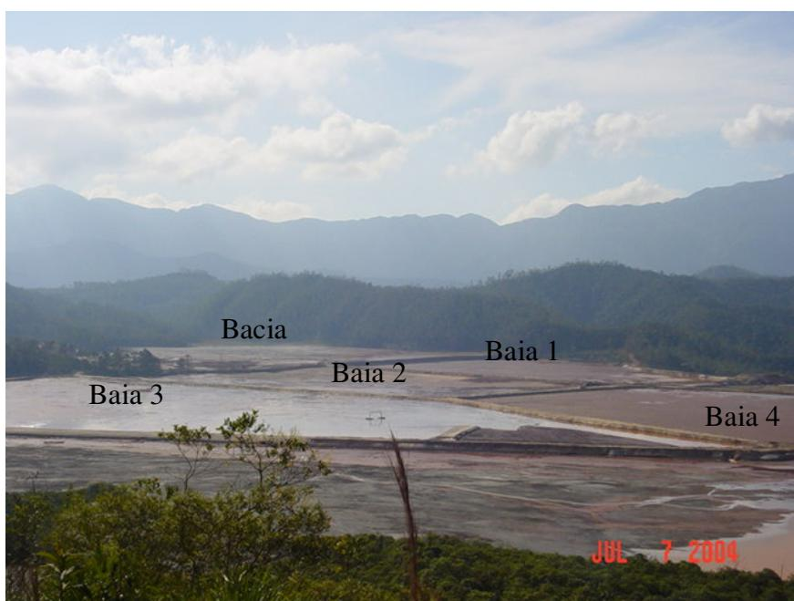
Figura 5.1 – Baias de ressecamento de lama/Samarco Mineração S.A.
