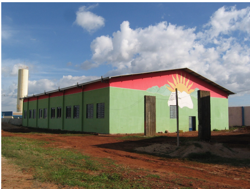
Foto 3 - Prédio reformando, onde funcionará a biblioteca e laboratórios. Fonte: Jovana A. Cestille
