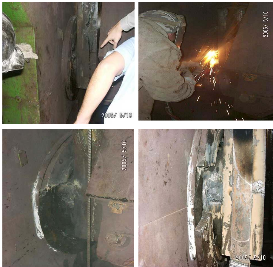
FIGURA 3.5 – Fase inicial para preparação do local de fixação dos sensores
