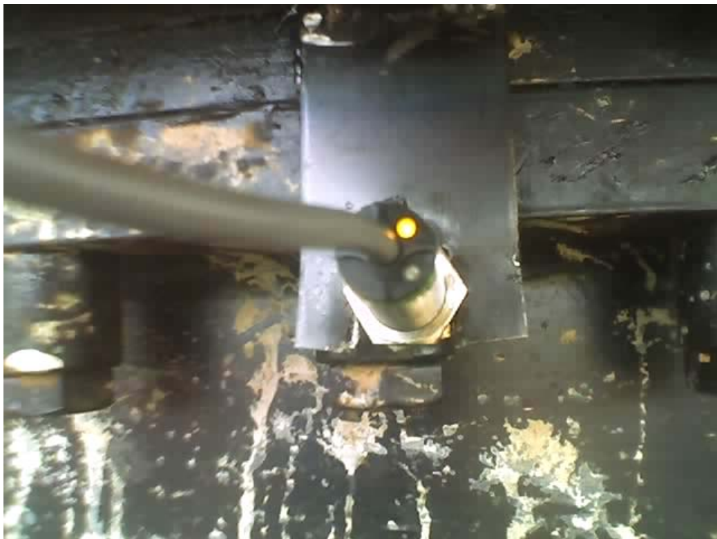
Figura 5 – Posição do sensor instalado na base da máquina.
