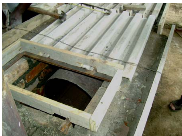
Figura 15: Construção da laje do combustor.
