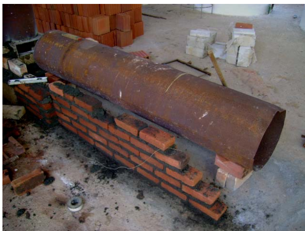
Figura 12: Vista do tubo no interior do combustor.
