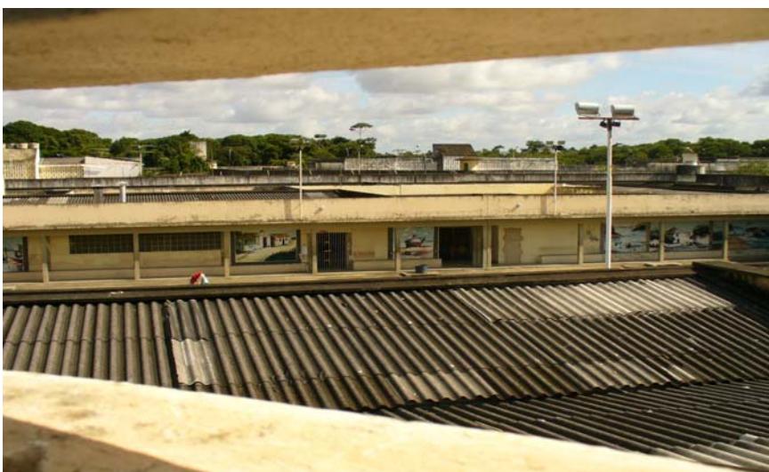
Foto 06 – Torre de Visibilidade 2 (Mônica Gusmão)
