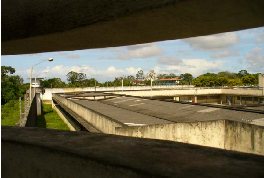
Foto 07 – Torre de Visibilidade 3 (Mônica Gusmão)
