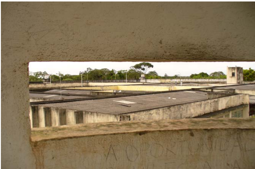
Foto 05 – Torre de Visibilidade 1 (Mônica Gusmão)
