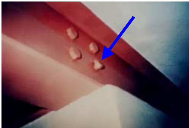
Figura 55 - Parafuso "torto" devido a erro na locação do furo – BETINELI 12 , ZACARIAS 55
