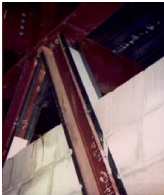
Figura 107 - Contraventamento + junta telescópica
