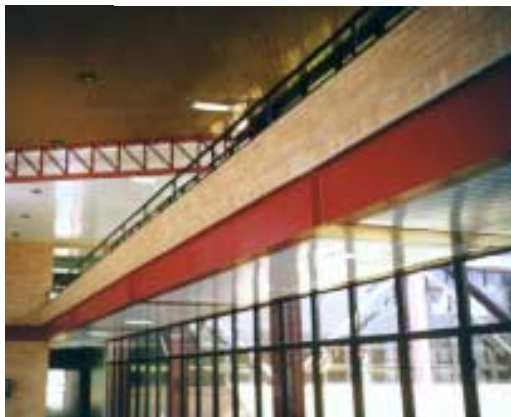
Figura 98 - Detalhe de alvenaria sobre viga contínua
