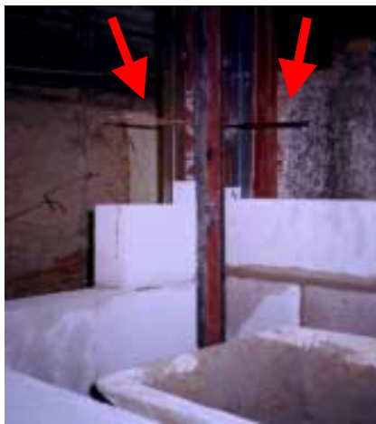
Figura 89 – Junta telescópica com ferro "cabelo"
