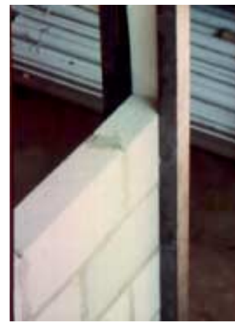
Figura 90 - Junta telescópica sem ferro "cabelo"
