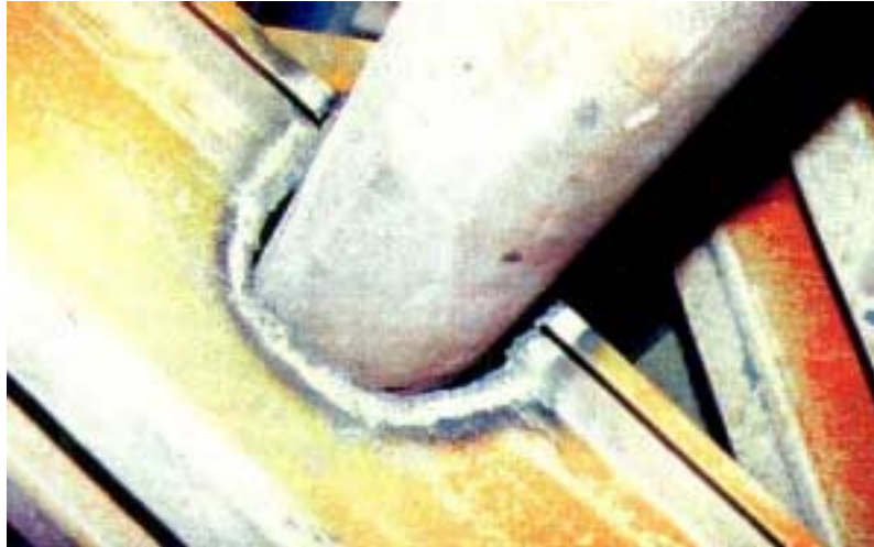
Figura 110 - Seccionamento de perfil estrutural para passagem de tubulação - – SOUZA 62
