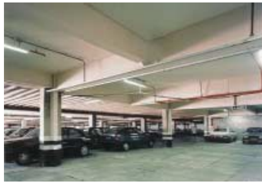
Figura 73 - Estrutura metálica com laje maciça
