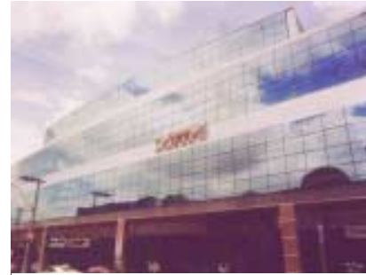
Figura 83 – Fachada de vidro
