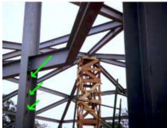
Figura 84 - Ferros "cabelo" para receber alvenaria solidarizada em pilar metálico
