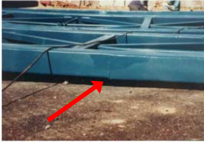
Figura 46 - Não coincidência entre perfis de diferentes dimensões – BETINELI 12 , ZACARIAS 55
