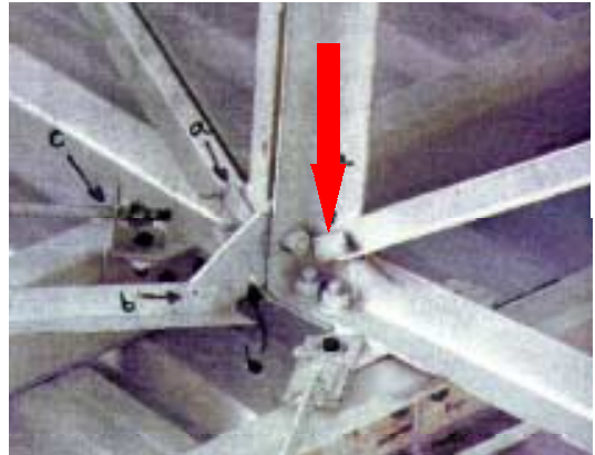
Figura 49 - Amassamento em ligação para possibilitar o acesso das chaves de aperto – SANTOS 62
