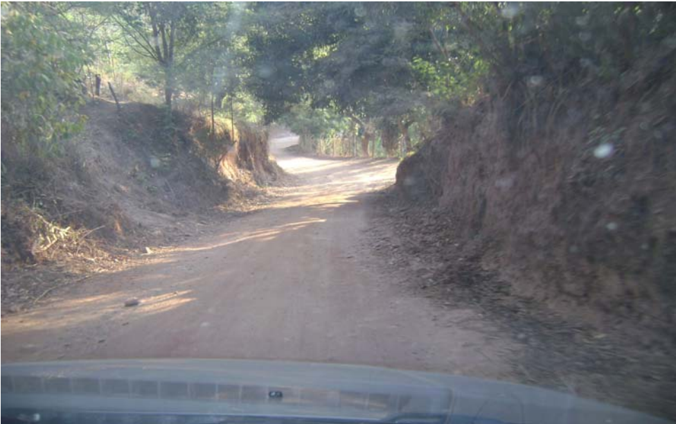
Foto 01: Estrada de acesso à Comunidade de Barro Preto, Santa Maria de Itabira / MG. 13 de setembro de 2008.
