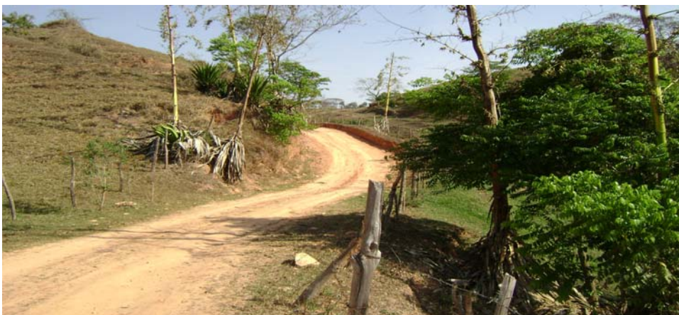
Foto 07: Estrada de acesso à Comunidade de Barro Preto, Santa Maria de Itabira / MG. 13 de setembro de 2008.
