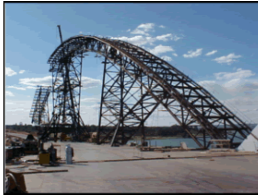
FIGURA 04 - Exemplo de estrutura Treliçada
