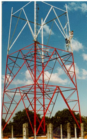
FIGURA 02 - Exemplo de estrutura Treliçada
