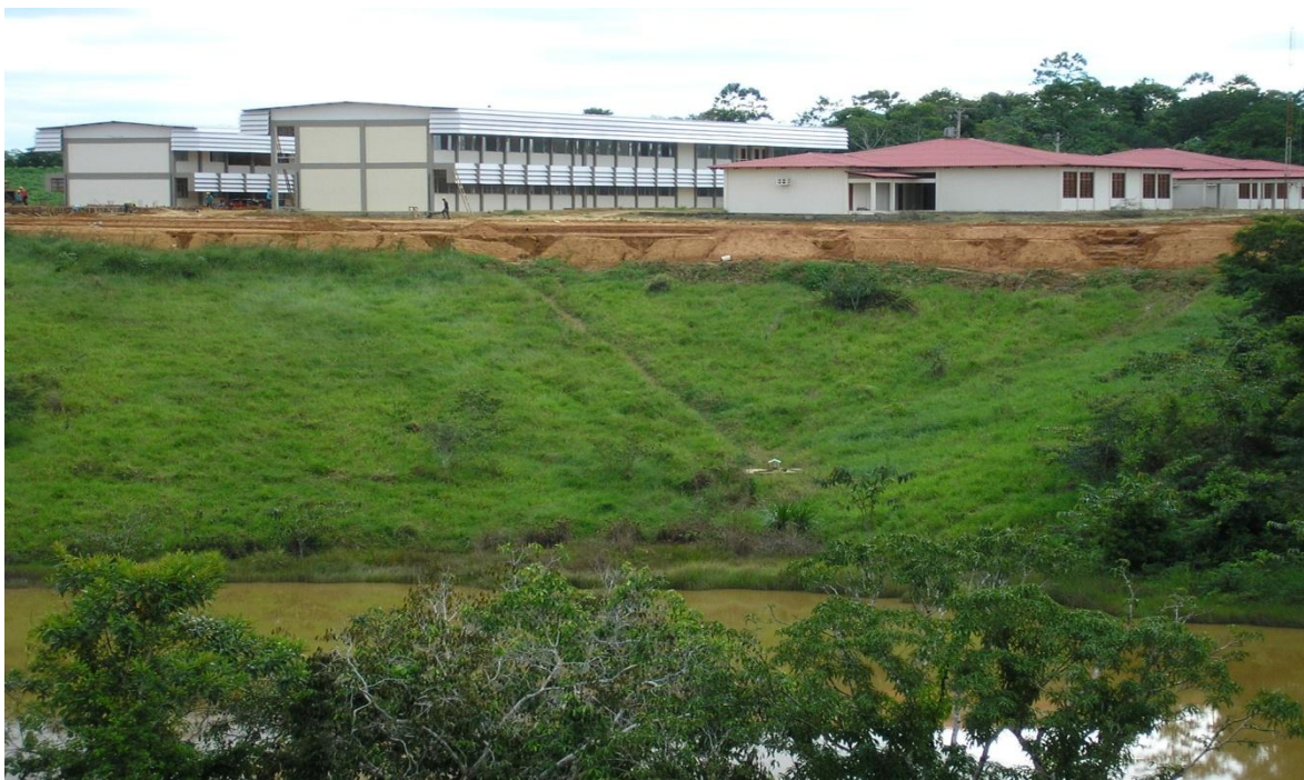
Figura 09: Blocos de Salas de Aula e Laboratórios do Campus Canela Fina. Fonte: UFAC - Assessoria de Comunicação, 2009.
