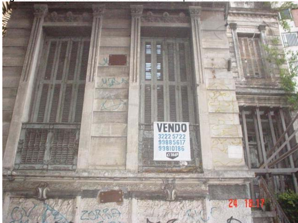
Figura 01: Casa situada no entorno do Centro Arquitetônico de Nazaré
