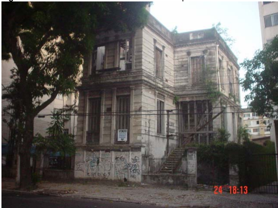
Figura 02: Casa situada no entorno do Centro Arquitetônico de Nazaré
