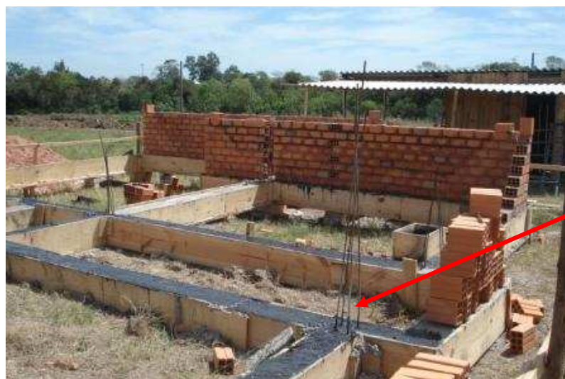
Figura 11: Início das alvenarias
