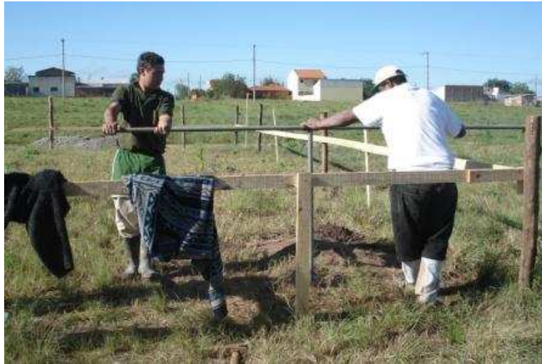
Figura 10: Trabalho manual de escavação das fundações
