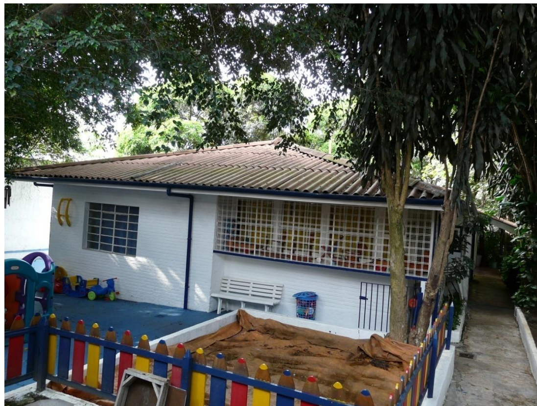
VISTA DA FACHADA PARA RUA ANTÔNIO DAS CHAGAS
