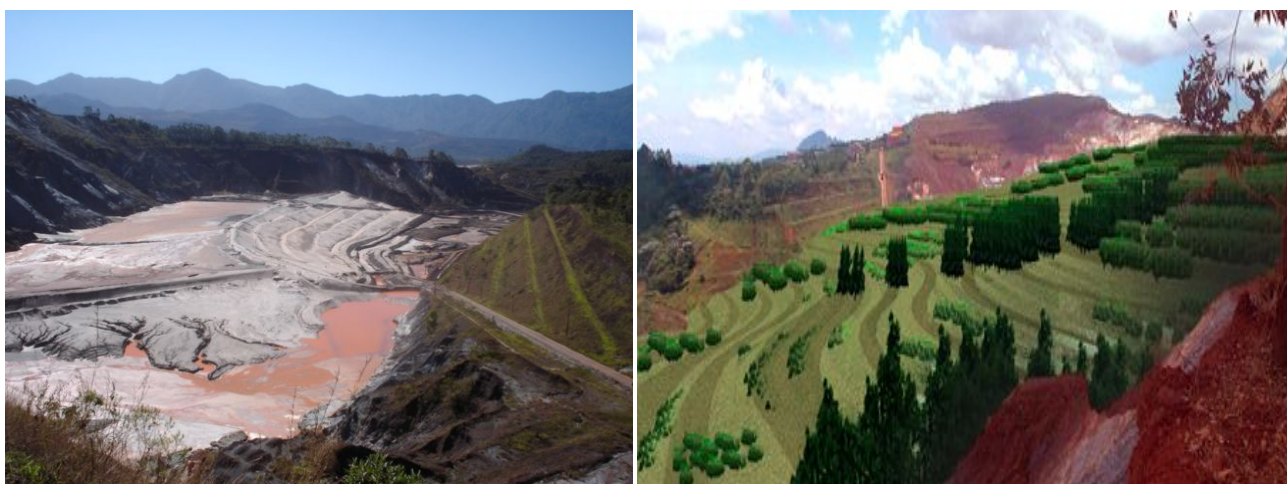
Figura 27: À esquerda situação atual da cava do Germano e à direita ilustração da cava após reabilitação (Fonte: Samarco).
