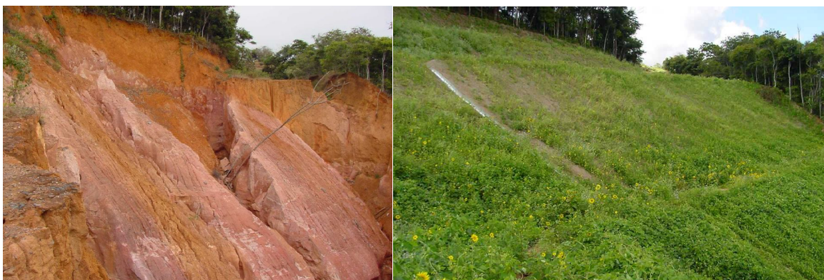
Figura 14: Imagens antes (2000) e depois (2002) da reabilitação ambiental de taludes na mina de Piçarrão (Fonte: CVRD).
