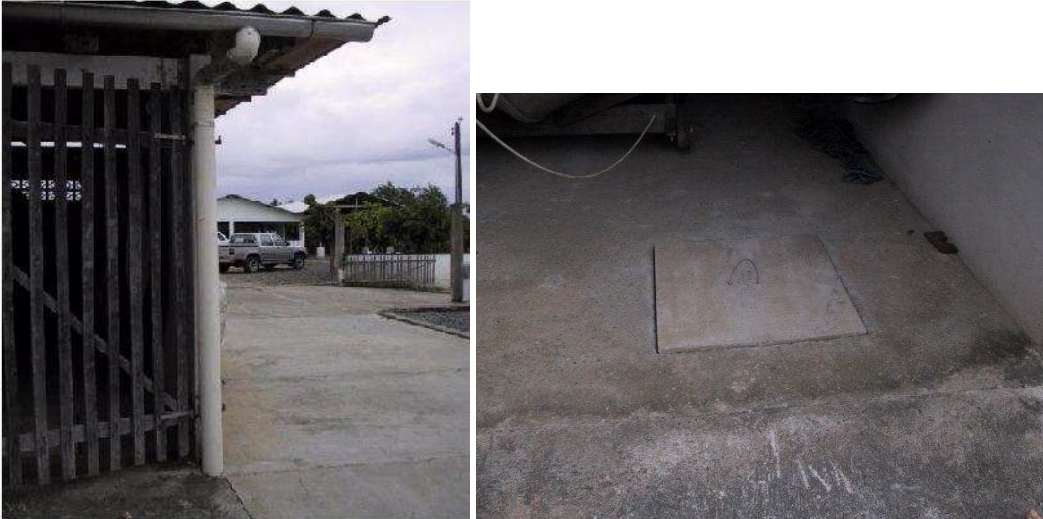
Figura 15 – Tubulação que conduz a água das calhas coletoras para cisterna e tampa da cisterna enterrada
