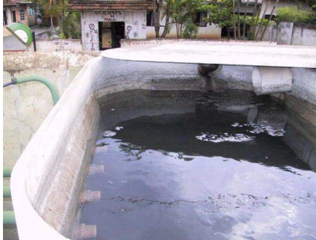
Figura 8 – Aspecto interno do reservatório de decantação e tubos de saída para a caixa d'água
