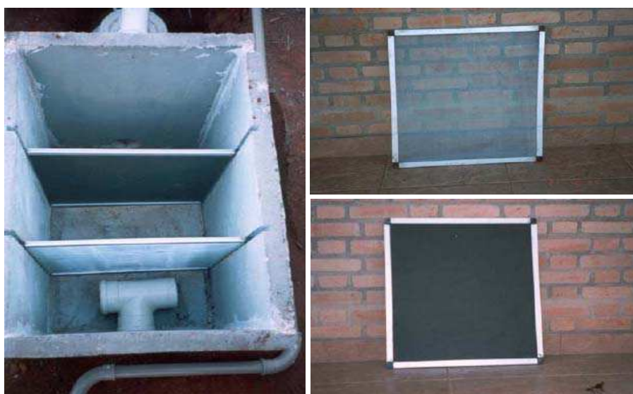
Figura 28 – Sistema de retenção de partículas sólidas
