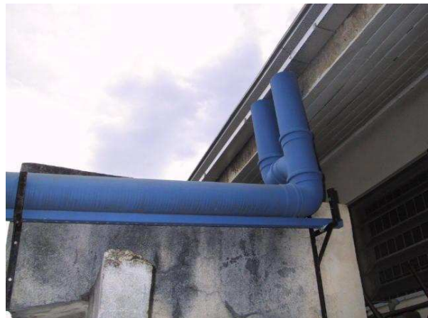
Figura 7 – Área de captação e calhas coletoras e Tubos que conduzem a água do telhado para o reservatório de decantação
