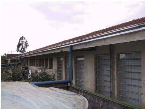
Figura 7 – Área de captação e calhas coletoras e Tubos que conduzem a água do telhado para o reservatório de decantação
