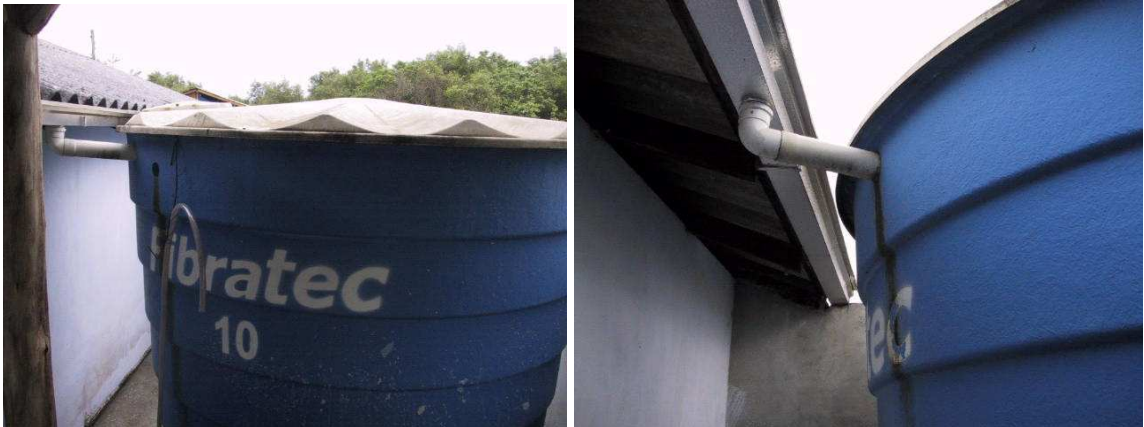
Figura 13 – Área de captação e uma das cisternas de 10.000L adicionais e tubulação de descida das calhas coletoras para a cisterna
