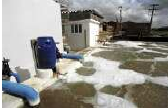
Figura 3 – Reservatório de 1.500 m 3 que armazena água de chuva juntamente com a água de refrigeração para reúso
