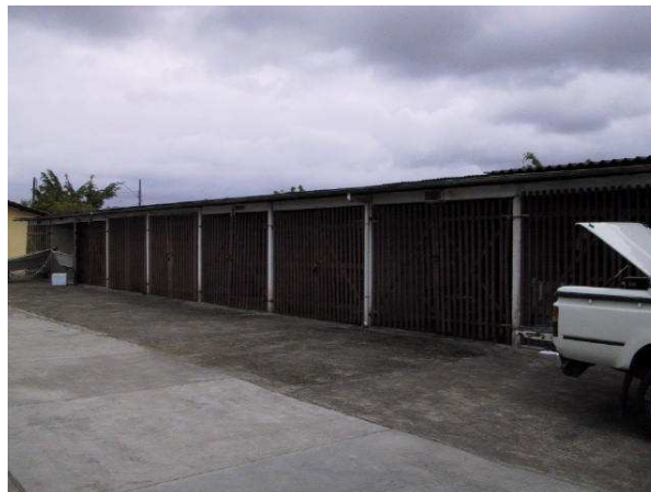
Figura 12 – Área de captação: telhado sobre o abrigo das embarcações
