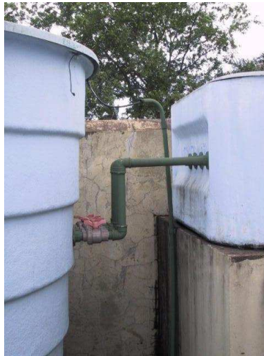
Figura 9 – Tubos que conduzem a água do reservatório de decantação para a caixa d'água
