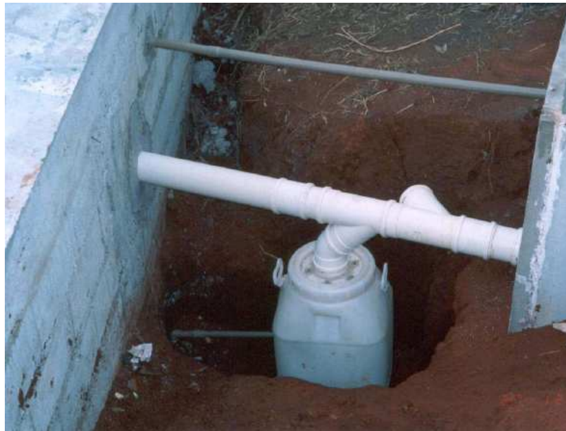
Figura 27 – Tonel de descarte da primeira água precipitada
