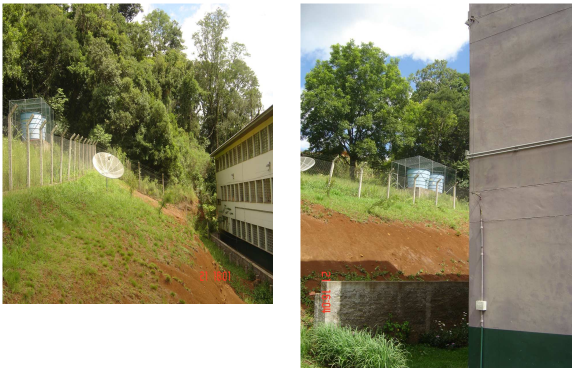
Figura 48 – Localização do reservatório de água de chuva superior.
