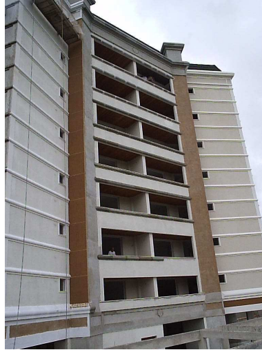
Figura 17 – Colunas onde estão embutidas as tubulações de descida da água de chuva coletada do telhado
