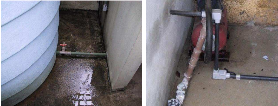
Figura 10 – Saída da caixa d’água para a bomba elétrica e bomba elétrica que conduz a água da cisterna para a caixa elevada sobre os sanitários
