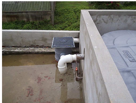
Figura 18 – Filtro instalado antes da entrada de uma das cisternas de 1000L
