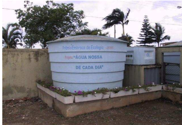
Figura 6 – Caixa d'água utilizada como reservatório para a água de chuva
