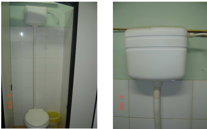
Figura 40 – Caixa de descarga de sobrepor e sistema de bacia sanitária
