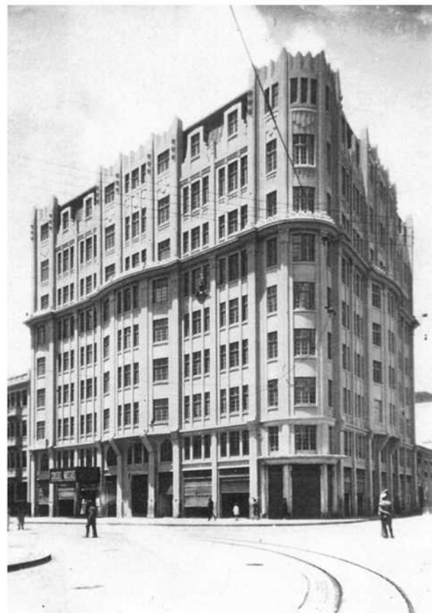
EDIFÍCIO MOREIRA GARCEZ Companhia Construtora Nacional S.A. Curitiba – Paraná, 1926. FONTE: CRUZ, A. p.143.
