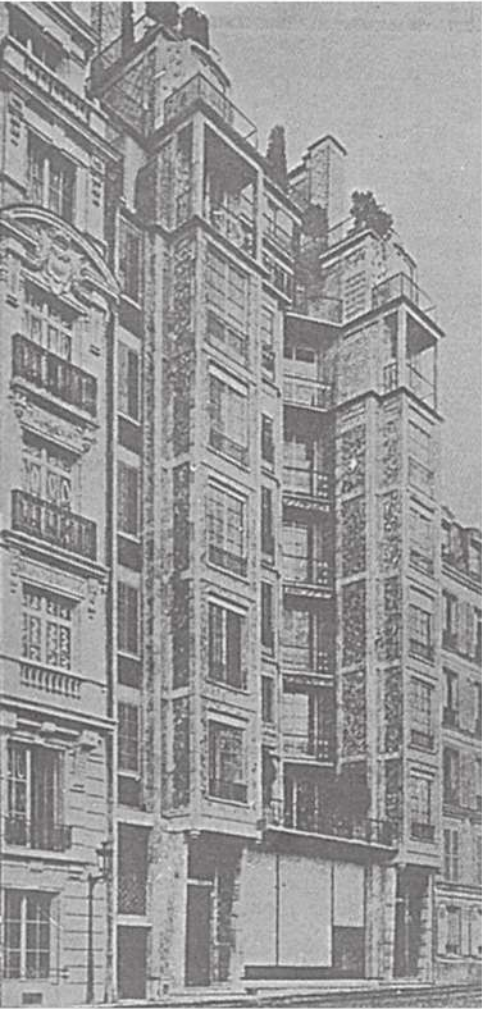
Auguste Peret Edifício de apartamentos Rue Franklin, Paris, 1903. Uso pioneiro do concreto armado para edificações. FONTE: BANHAM, R. p.66.
