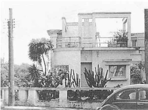
Residência Frederico Kirchgässner 1.ª Edificação em arquitetura moderna de Curitiba. FONTE: DUDEQUE, I. p.94.
