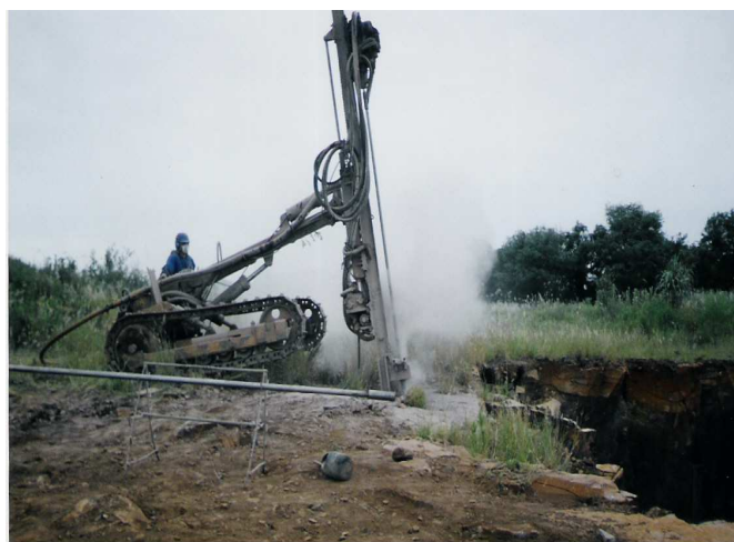
Figura 29 - Perfuração de pedreira usando perfuratriz Wagon-Drill.
