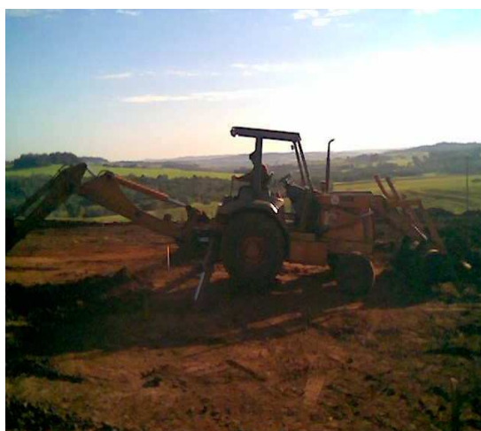
Figura 27 - Capeamento mecânico da pedreira
