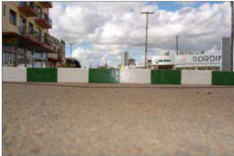
Figura 53 – Afundamento em trilha de rodas
