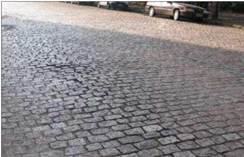
Figura 11 – Pavimento de paralelepípedos
