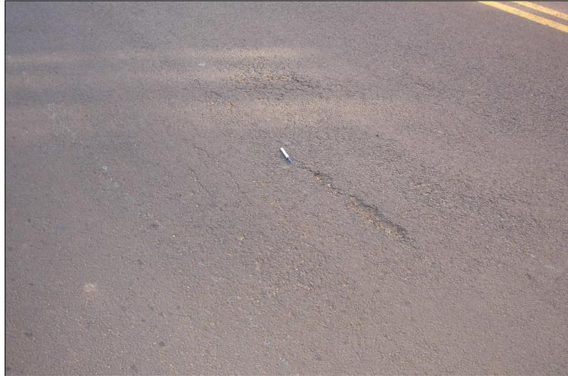
Figura 48 – Desagregação Superficial
