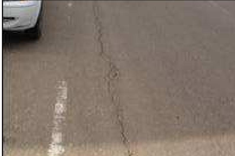
Figura 43 – Trincamento Longitudinal
