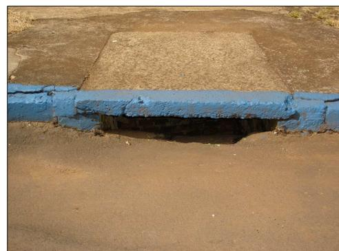
Figura 3 – Dispositivo de captação
