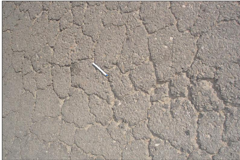
Figura 39 – Trincamento por Fadiga
