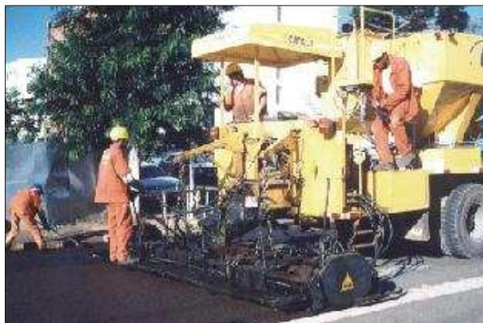
Figura 20 – Aplicação de MRA sobre pavimento deteriorado
