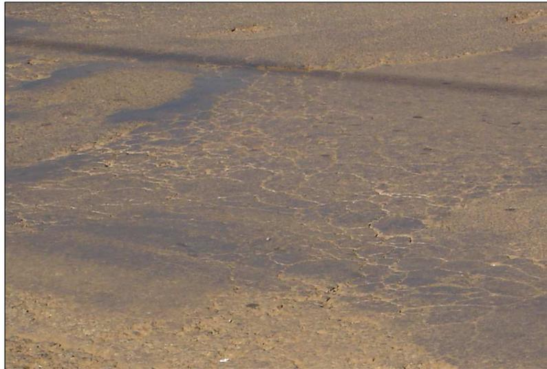
Figura 41 – Trincamento por Reflexão
