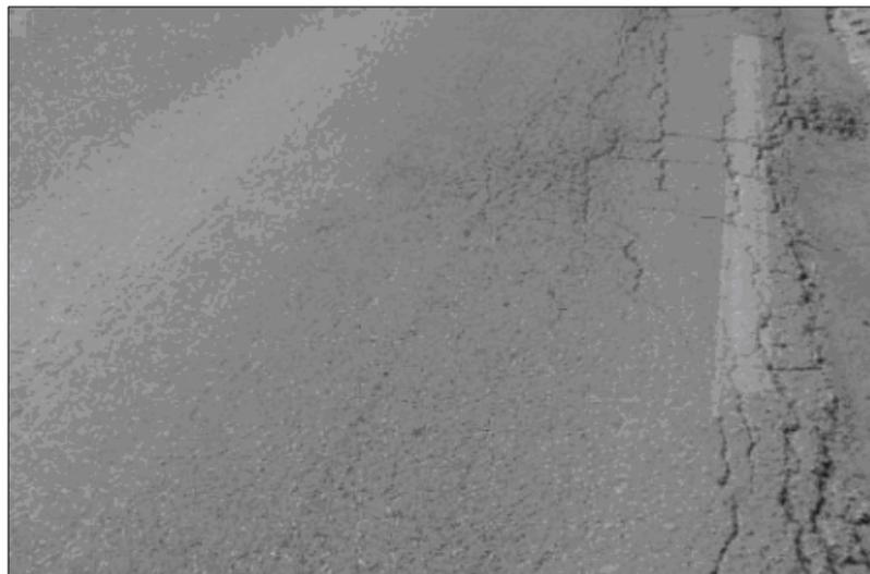
Figura 45 – Trincas de bordo
