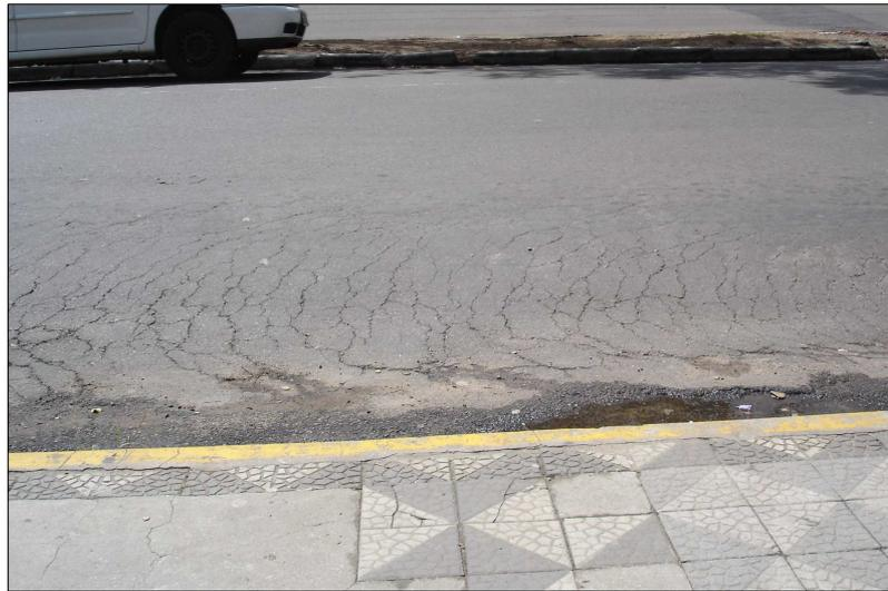
Figura 44 – Trincas de Escorregamento
