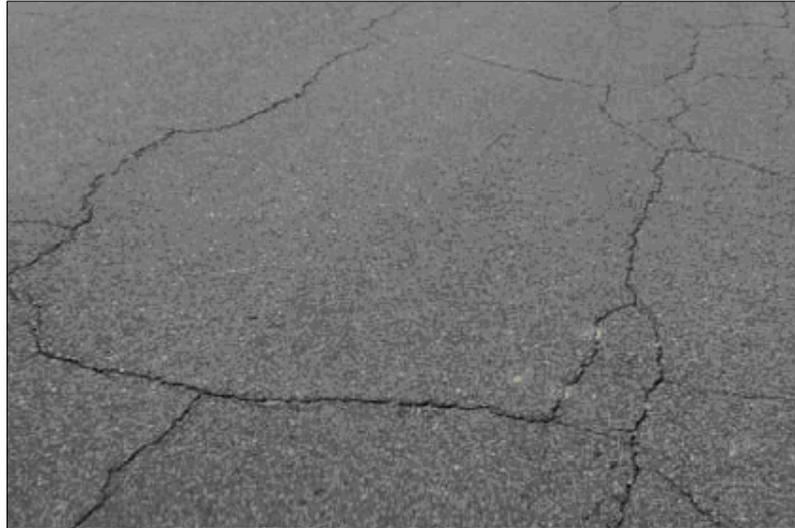
Figura 40 – Trincamento em Bloco
