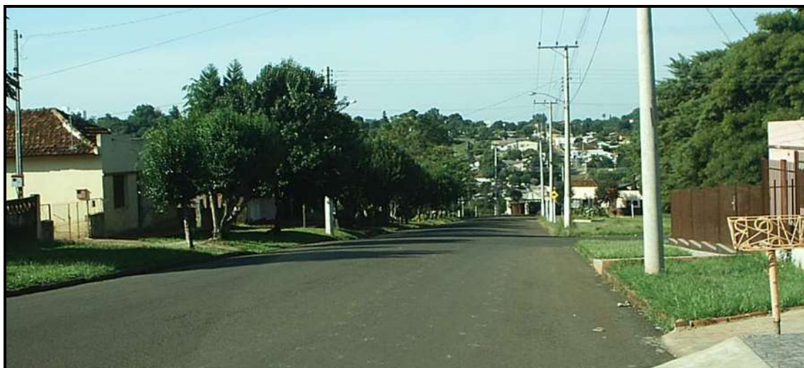
Figura 127 – Passeio em frente às residências do entorno.
