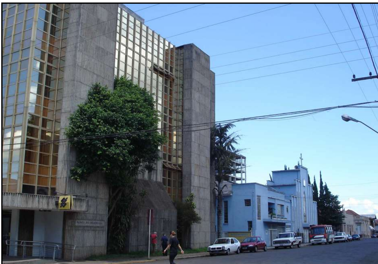
Figura 44 – Edificações localizadas ao sul da Praça.
