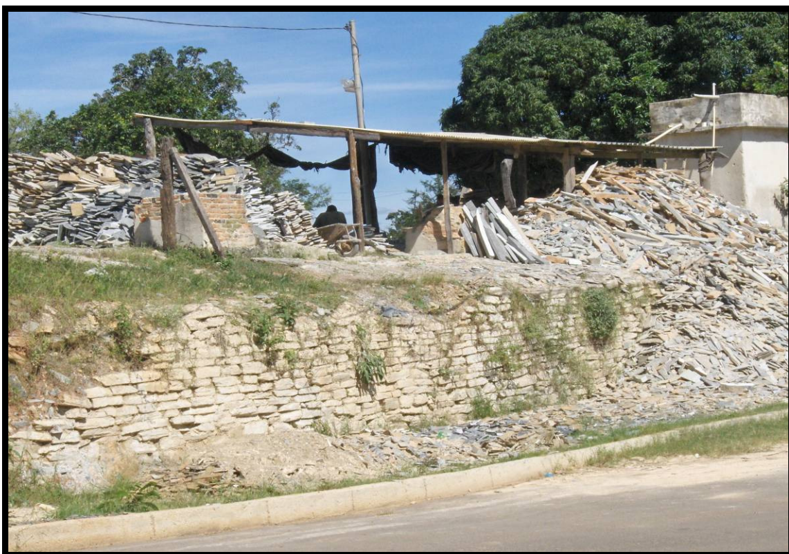
FIGURA 4.15 – Poluição visual gerada pela deposição de rejeitos em via pública (Dezembro de 2007)
