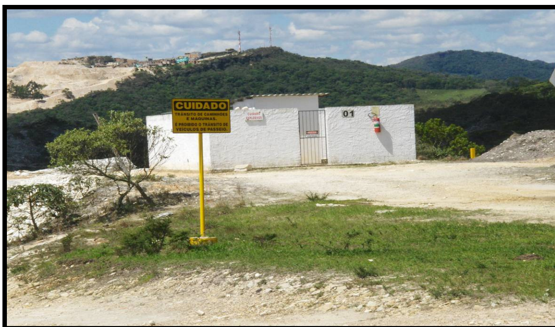
FIGURA 2.17 – Disposição de explosivos em local apropriado (Novembro de 2007)
