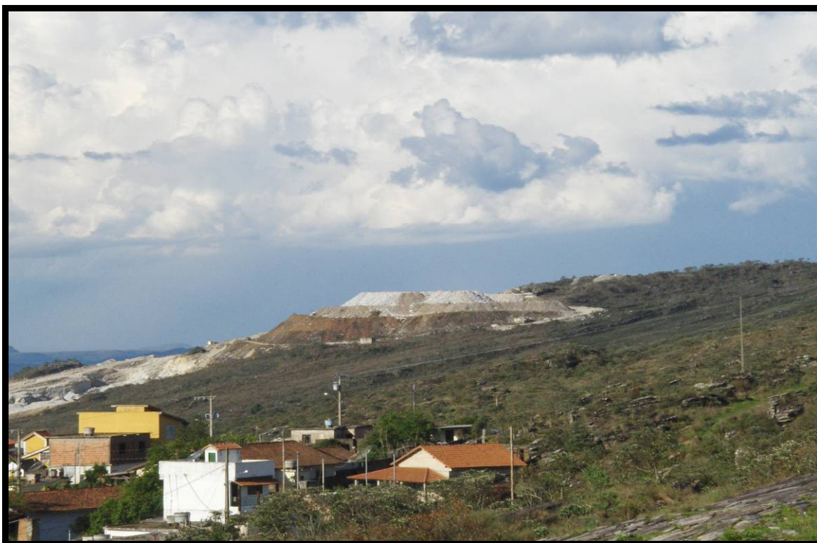
FIGURA 2.15 – Reconformação e revegetação de uma pilha de rejeito de uma pedreira da pedra São Tomé
