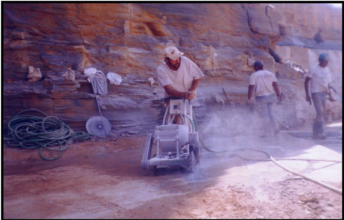
FIGURA 4.4 – Unidade de extração mostrando uma frente de lavra em operação
