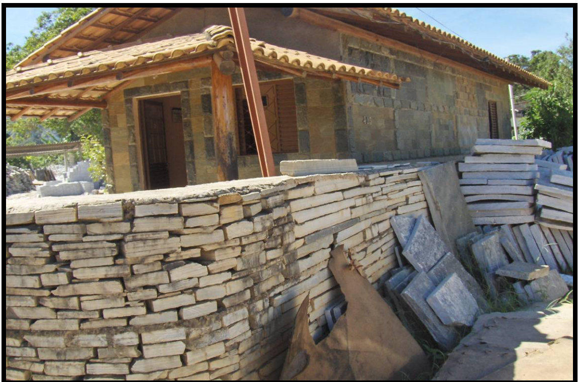
FIGURA 2.6 – Emprego da pedra Lagoa Santa no revestimento de paredes e como muro (Janeiro de 2008)
