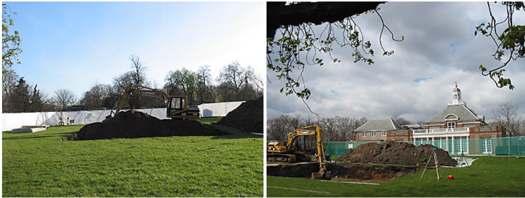
31 de março a 2 de abril. Início das escavações.
