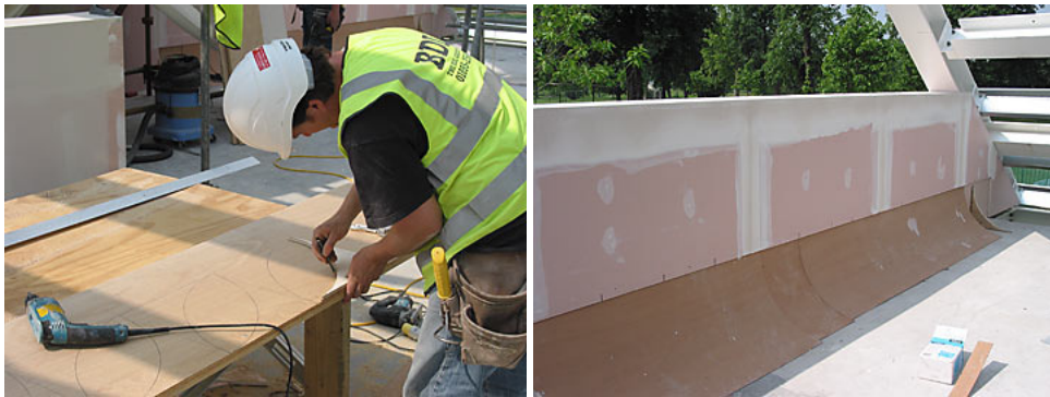
Operário recortando o molde que permite a interseção da parede e da laje do primeiro pavimento de forma curva. Externamente não se percebe indícios dessa forma.
