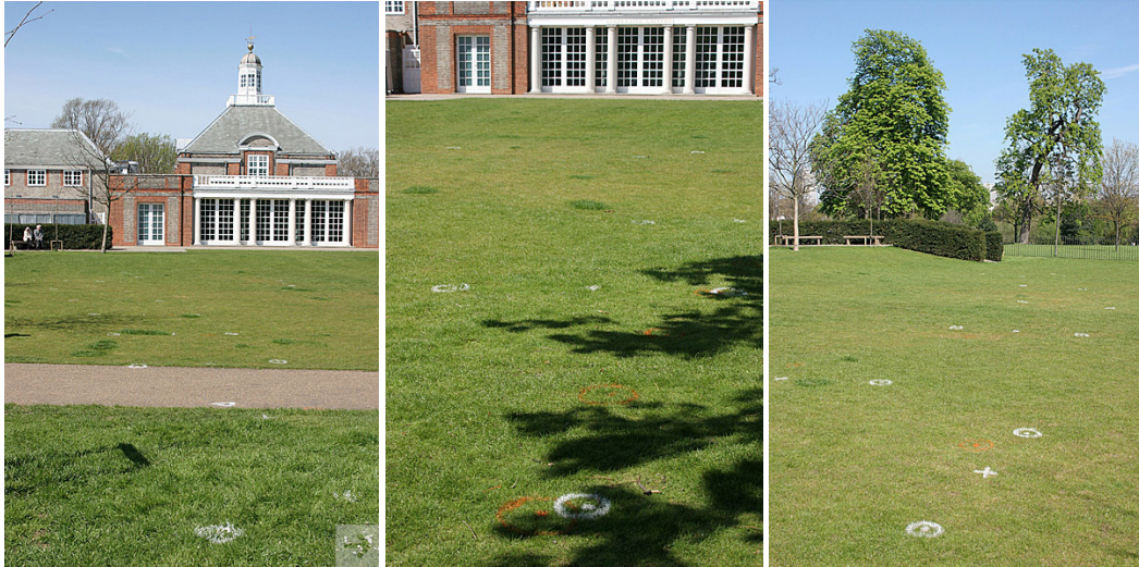
Marcação das sapatas no terreno em frente a galeria Serpentine | 17 de abril de 2005.
