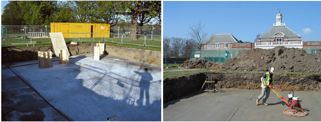
Concretagem da laje do piso semi-enterrado. 4 a 7 de abril.
