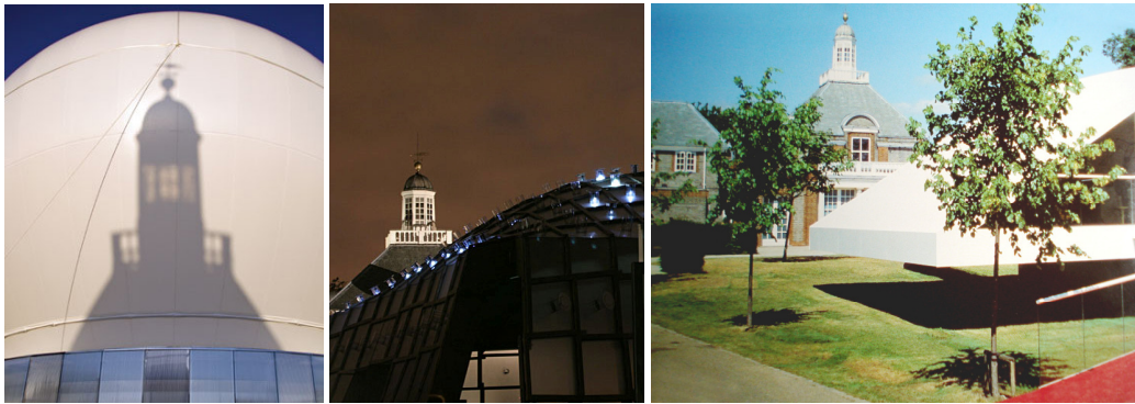
Pavilhões da Galeria Serpentine de Ren Koolhas, Álvaro Siza e Oscar Niemeyer, com o prédio antigo em segundo plano.
