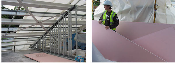
20 a 25 de maio de 2003. Colocação das chapas de gesso.
