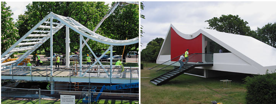
Contraste entre a leve e contemporânea estrutura em ferro da galeria e a aparência final que mascara seu sistema construtivo.
