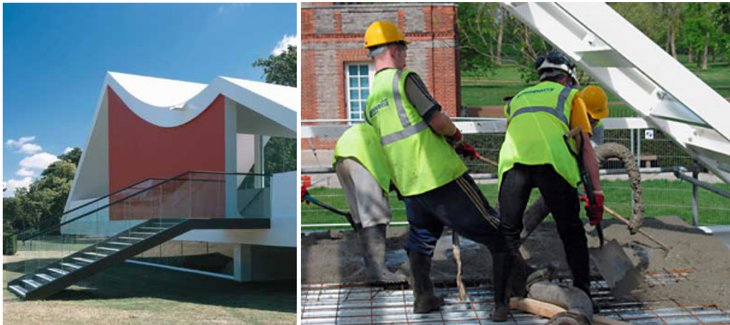
Contraste entre a leve e contemporânea estrutura em ferro da galeria e a tradicional concretagem da laje do primeiro pavimento.
