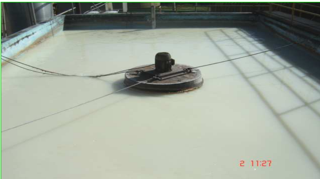
Figura 4: Foto do equalizador da ETE da indústria de laticínios.
