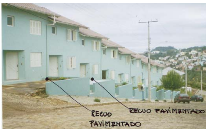
Figura 50: Recuo frontal pavimentado
