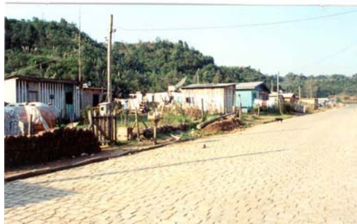
Fig. 109f: Ruas pavimentadas - Coopervale
