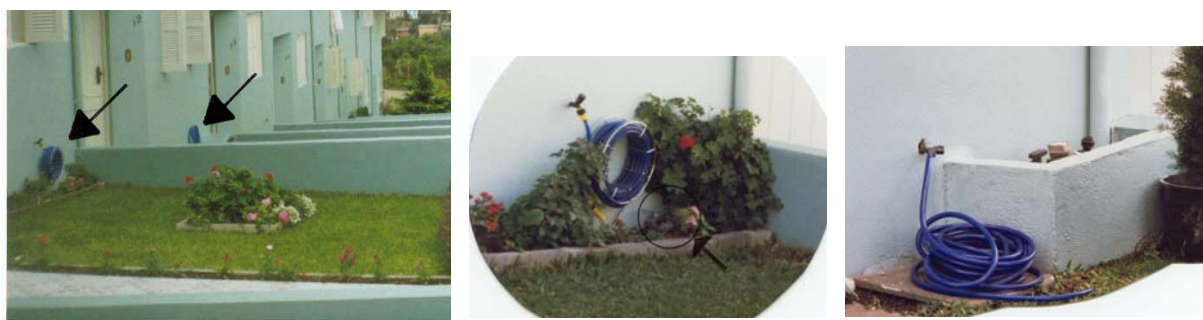
Figura 61: Hidrômetro para cada economia
