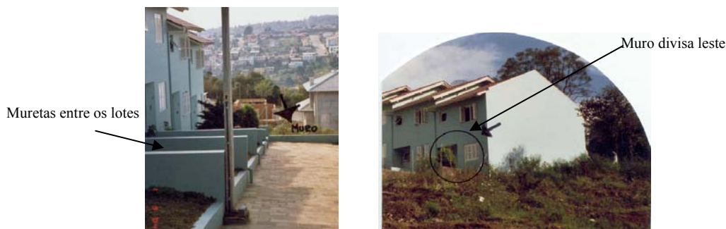
Figura 58: Muro na divisa com o lado leste
