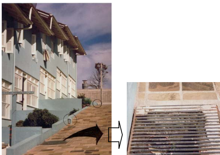
Figura 62: Coleta das águas da chuva
