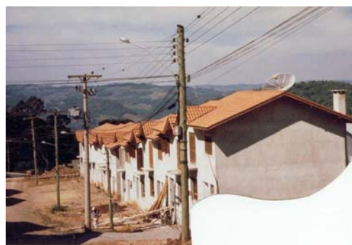
Fig.: 43: Rede de distribuição principal A rede de distribuição principal e de iluminação estão posicionadas na calçada. O posicionamento dos postes foi efetuado corretamente, visando, não só à iluminação das vias, mas também priorizando a iluminação nos acessos das habitações.
