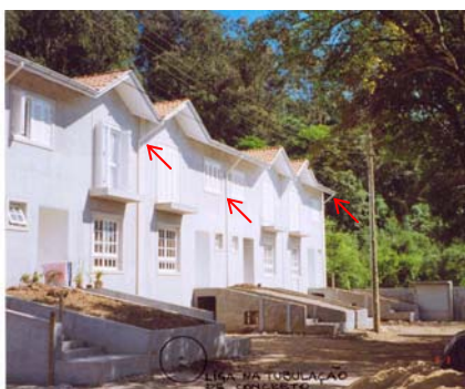
Figura 41: Recolhimento das águas pluviais
