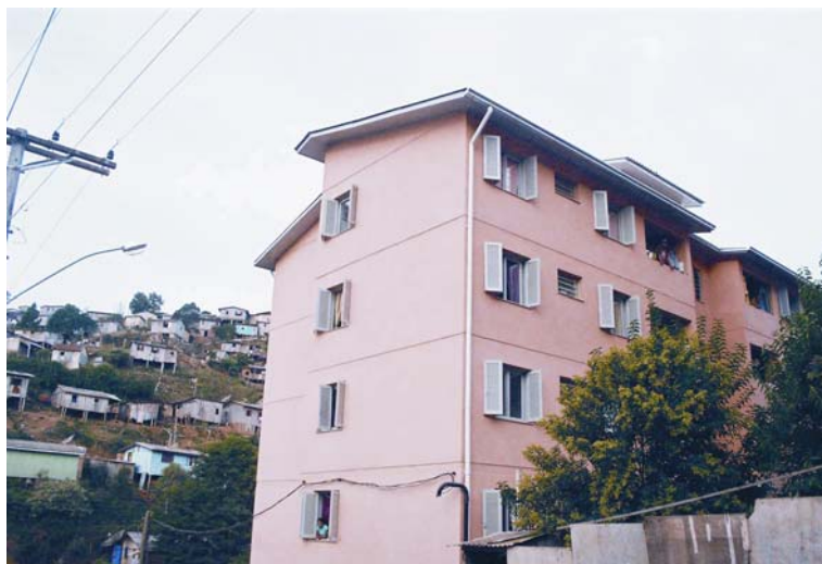
Fig. 109i: Construção de prédios – Coop-Canyon
