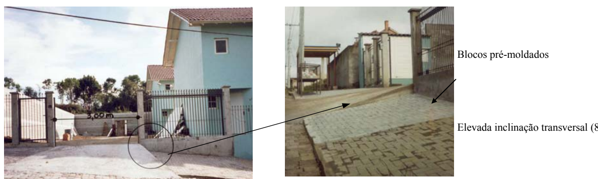
Figura 60: Rebaixamento do meio fio
