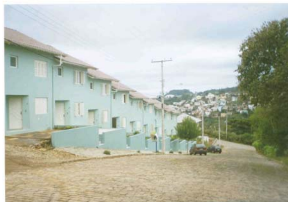
Fig. 105: Conjunto habitacional da cooperativa Novo Tempo, 2004 (foto1)
