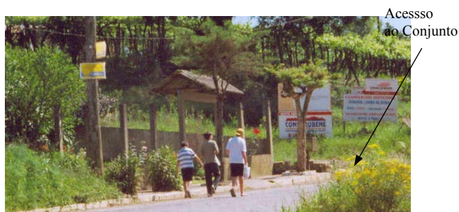
Figura 31: Ausência de calçada na rua Carlos D. Neto
