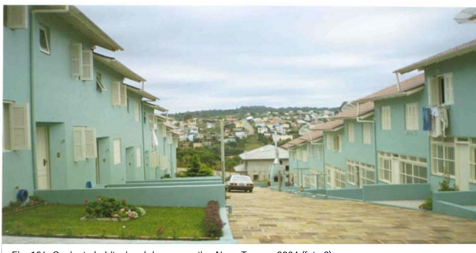
Fig. 106: Conjunto habitacional da cooperativa Novo Tempo, 2004 (foto 2)
