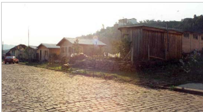
Fig. 109e: Pavimentação e divisão dos lotes - Coopervale
