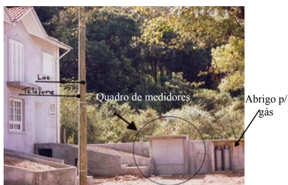
Fig. 42: Ponto de distribuição (poste), quadro de medidores e abrigo para gás.
