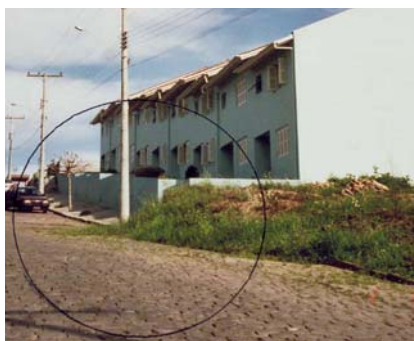
Figura 69: Deficiência do serviço de capina
