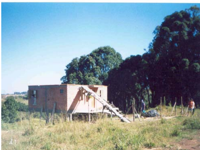
Fig. 119: Área da cooperativa Industrial (foto2).
