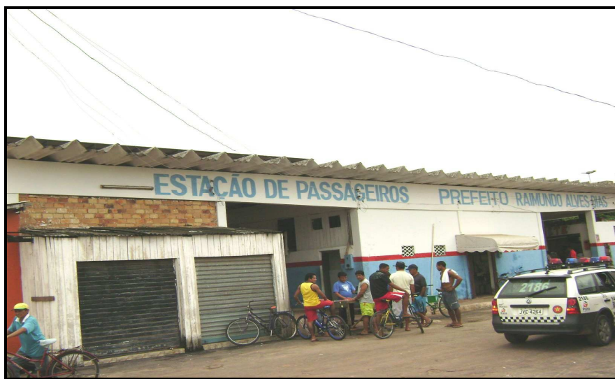
Figura 16: Fachada da estação de passageiro Prefeito Raimundo Alves Dias.
