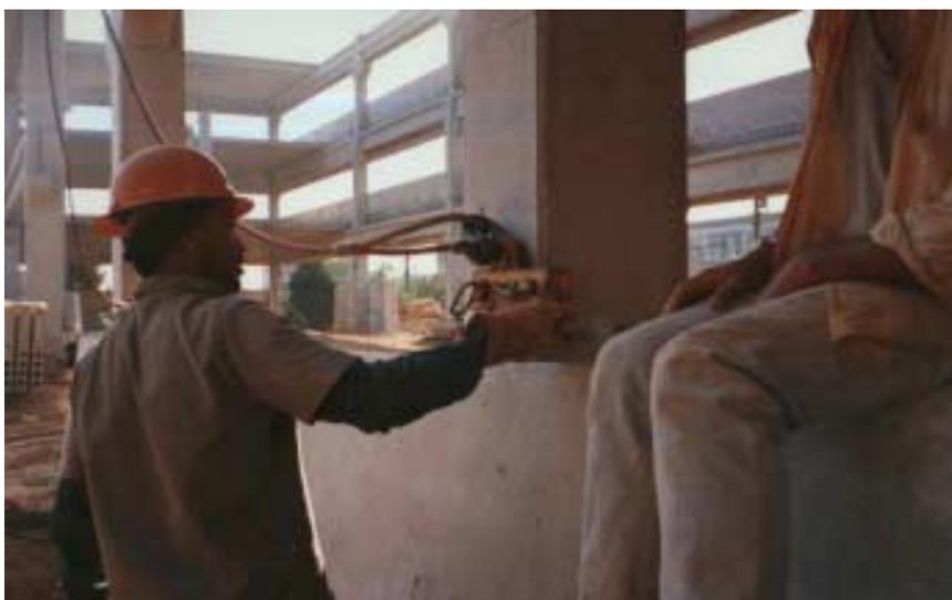
Figura 3.10 – Fixação dos ganchos de içamento no painel
