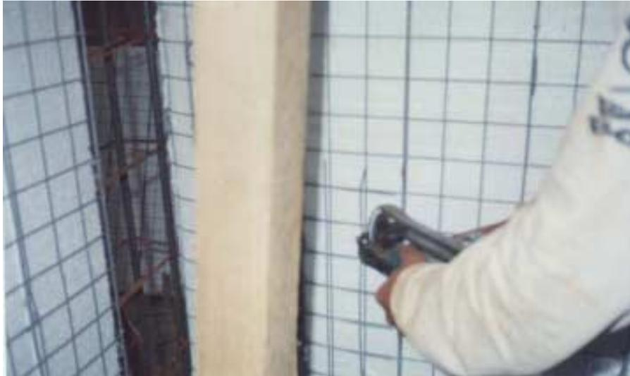
Figura 6.10 – Detalhe da fixação do trespasse da tela metálica utilizando arame
