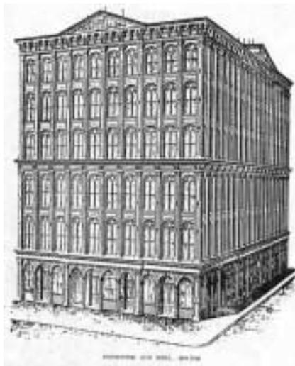
Figura 2.6 - Perspectiva de um edifício com fachada em ferro fundido (Silva, 1986)
