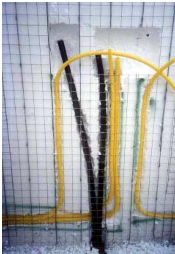
Figura 6.15 – Colocação de dutos entre a tela e o painel
