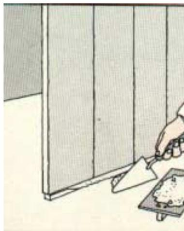
Figura 5.13 – Enchimento dos vazios sob os painéis (Siporex, 1999)
