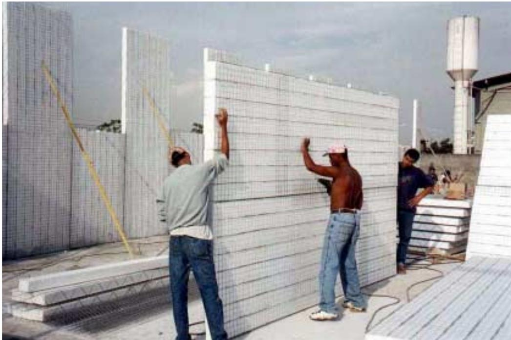
Figura 6.9 – Trespasse da tela metálica para fixação de um painel da High Tech junto a outro e amarração da tela com arame
