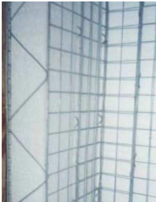
Figura 6.13 – Reforço de encontro entre paredes
