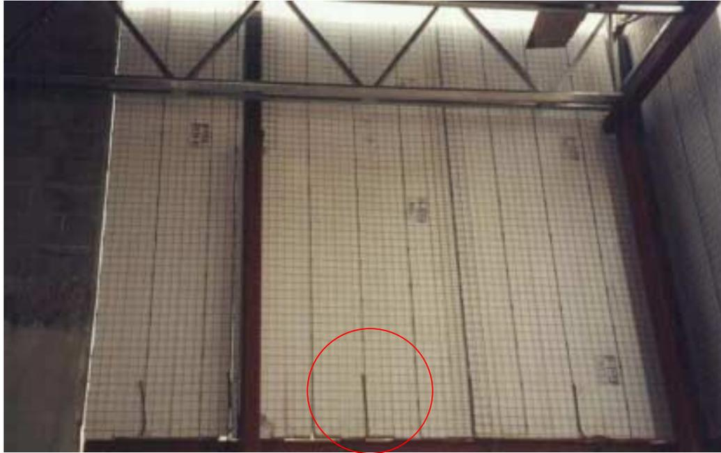
Figura 6.7 – Fixação dos painéis da High Tech à estrutura utilizando ferro cabelo
