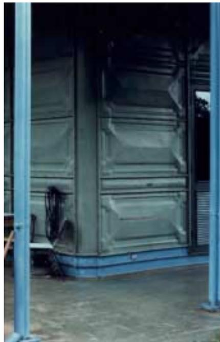
Figura 2.2 – Detalhe do painel em chapa metálica
