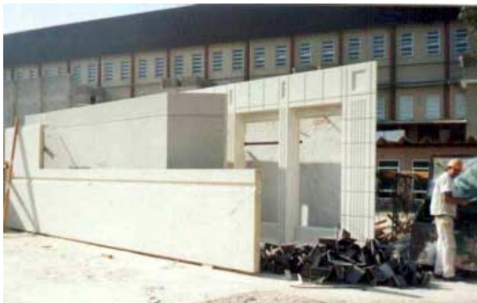
Figura 7.1 – Exemplo de algumas possibilidades de modelo de painéis pré-fabricados de concreto da STAMP
