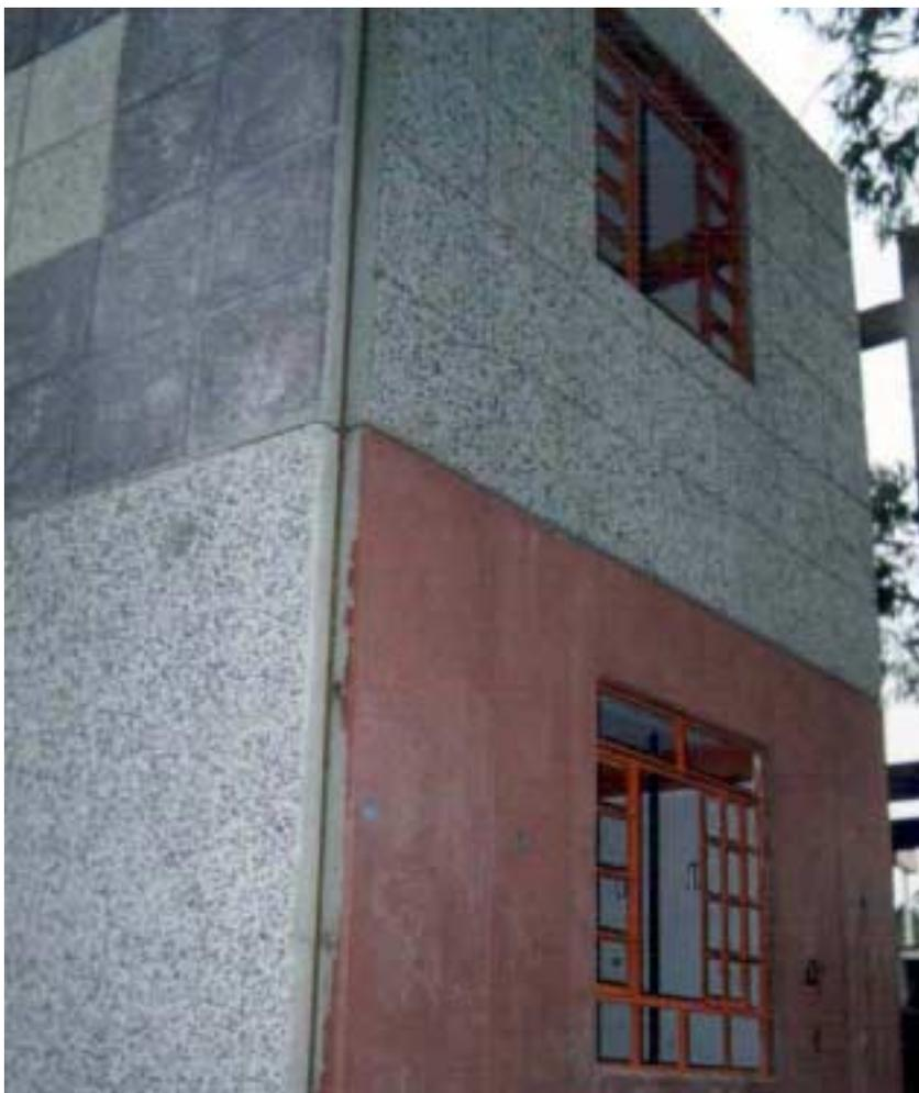
Figura 7.13 – Exemplo de painel cortina da Precon
