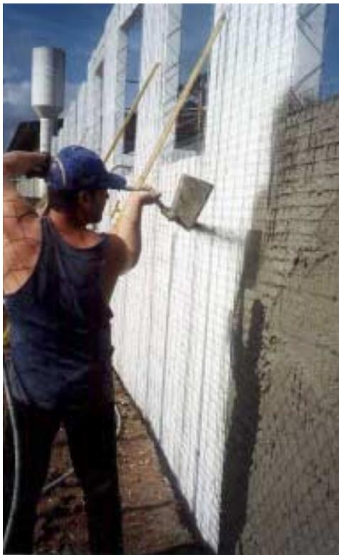
Figura 6.16 – Aplicação da argamassa utilizando projetor pneumático de argamassa junto a um painel de EPS da High Tech
