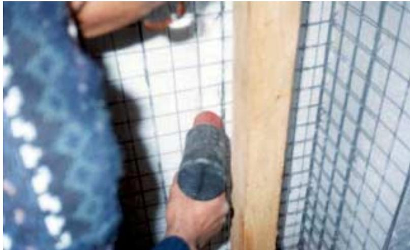
Figura 6.14 – Uso de gerador de ar quente para abertura das fendas para passagem de dutos
