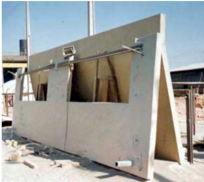
Figura 7.26 – Fixação dos painéis da STAMP através de *inserts* de seção quadrada
