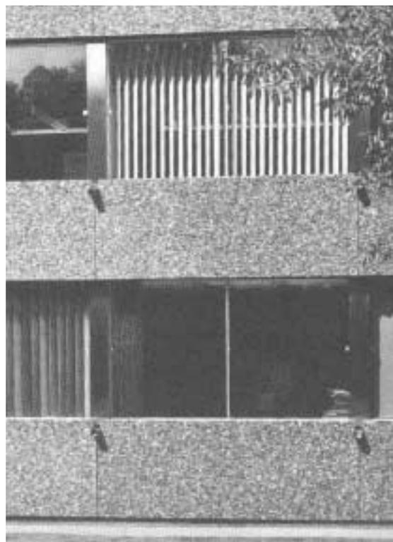
Figura 7.10 – Gárgula para condução da água pluvial para fora do prédio (PCI, 1973)
