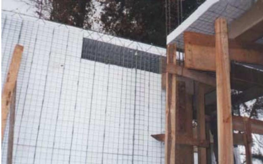
Figura 6.5 – Trespasse da tela metálica no encontro entre painéis
