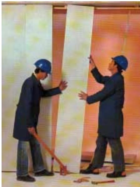
Figura 5.10 - Levantamento do painel com alavanca (Siporex, 1999)
