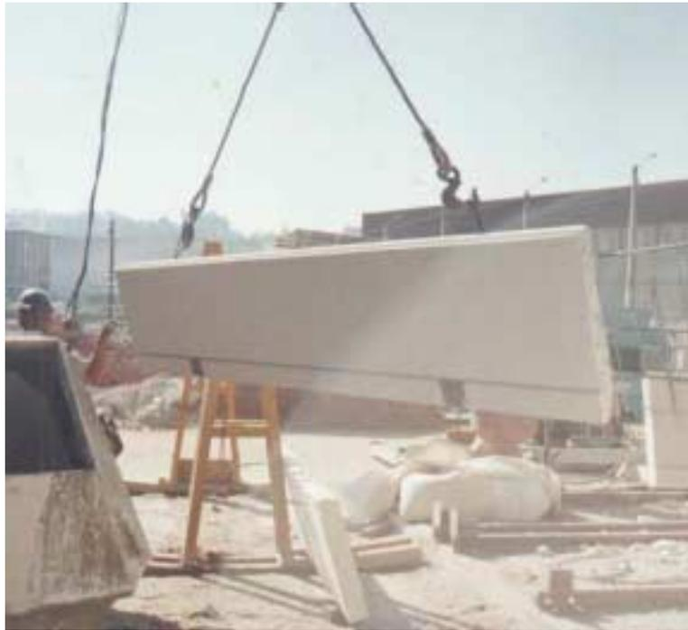
Figura 7.42 – Alças de cabo de aço para permitir içamento dos painéis
