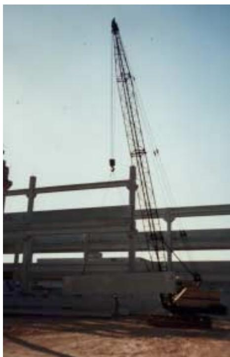
Figura 3.11 – Içamento do painel através de guindaste
