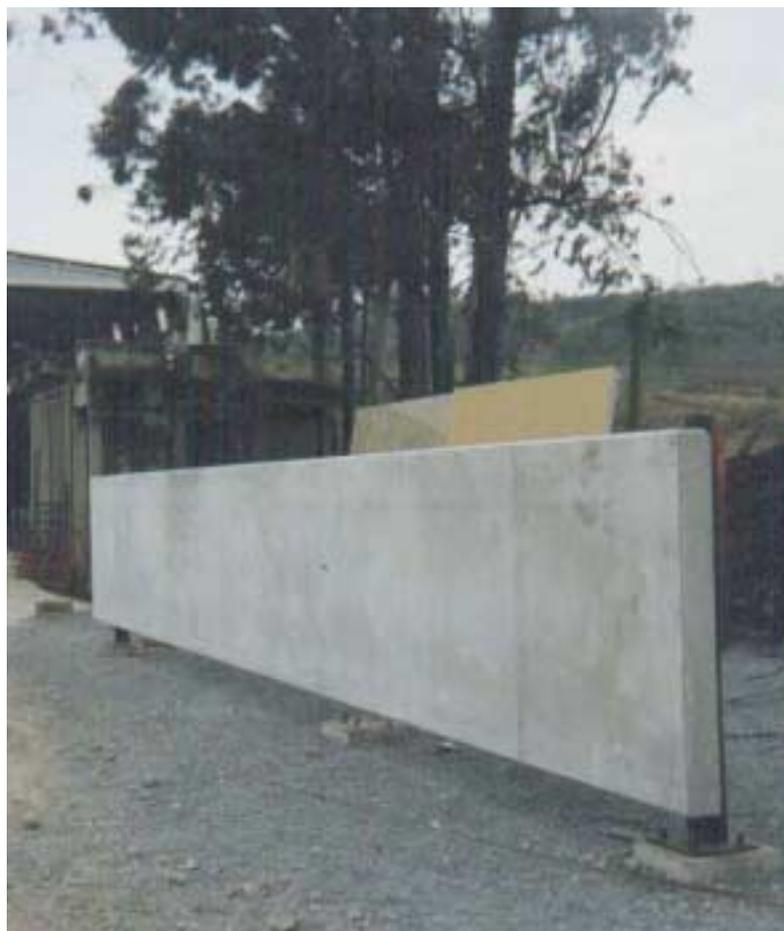
Figura 7.15 – Pannel de acabamento completamente liso da Precon
