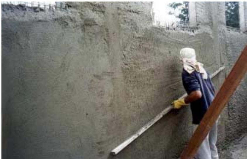
Figura 6.17 – Desempenamento da superfície após aplicação da argamassa nos painéis de EPS da High Tech
