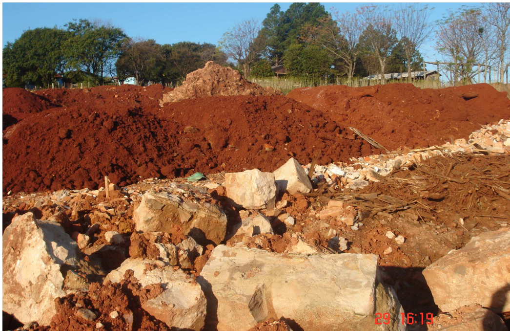
Figura 30 - Vista geral da área nº.6.
