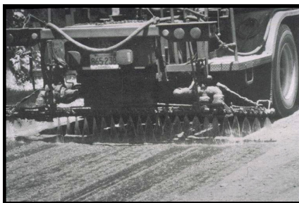
Figura 7 - Recuperação da rodovia usando FDR
