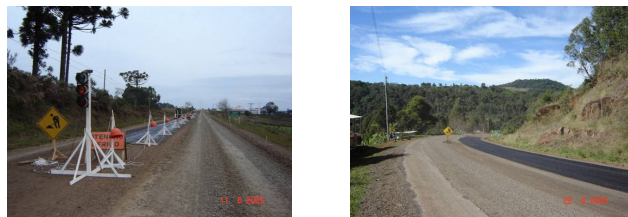
Figura 54 – Pista reciclada e imprimada
