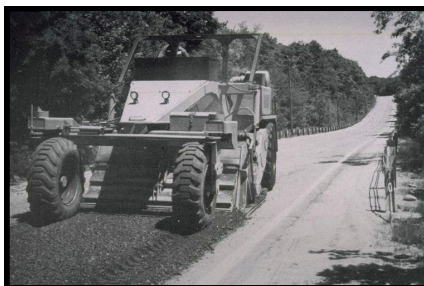
Figura 7 - Recuperação da rodovia usando FDR
