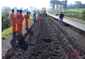
Figura 52 – Regularização do material reciclado
