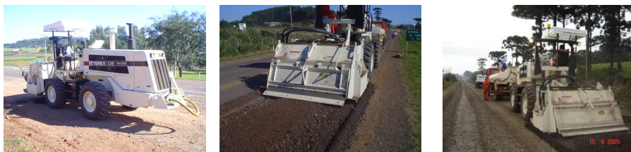
Figura 51 – Reciclagem do pavimento com a recicladora TEREX CMI – 3258
