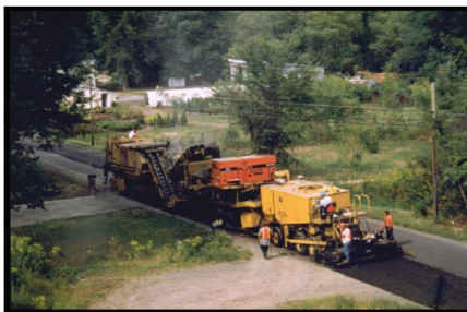
Figura 4 – Reciclagem a frio in situ
