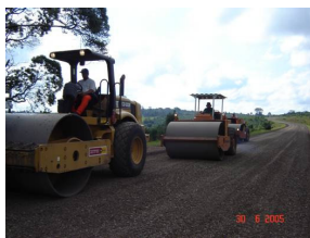
Figura 53 – Compactação da base reciclada
