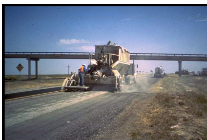
Figura 10 – Aplicação do cimento
