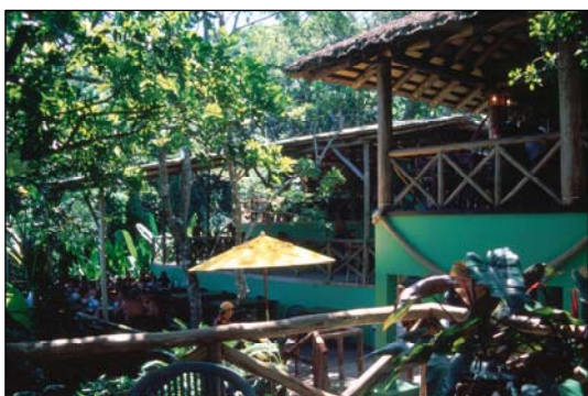
FIGURA 5 – Restaurante construído em níveis diferentes, adaptando-se à topografia
