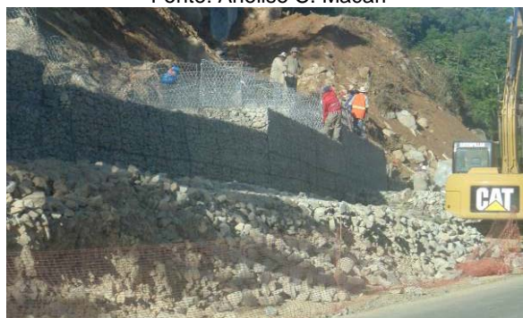
Figura 65: Obras de contenção que estão sendo realizadas ao longo da BR - 282.
