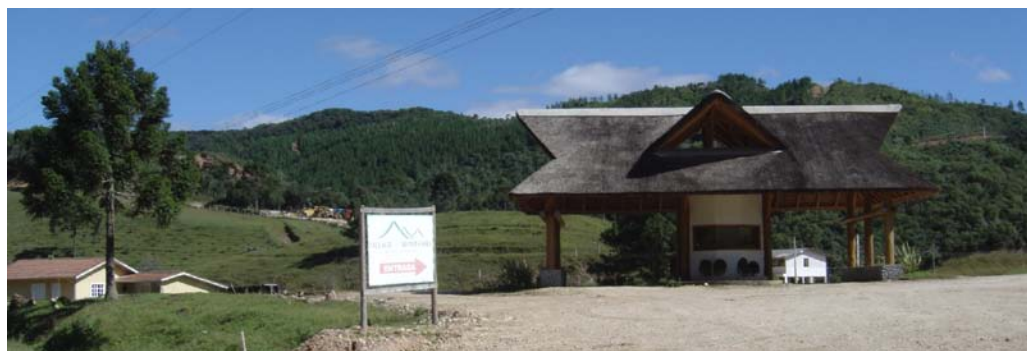
Figura 51: Condomínio Village da Montanha, ainda em processo de implantação.
