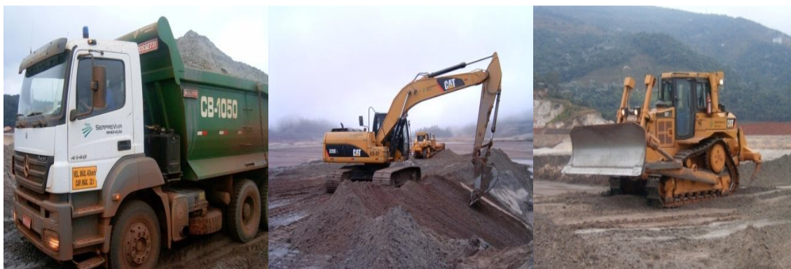
Figura 4.9 – Equipamentos de terraplenagem utilizados
