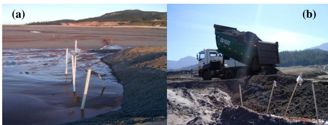
Figura 4.19 – (a) Avanço do forro lateralmente à instrumentação central (dia 14); (b) Avanço do forro agora pelos dois lados (dia 15)
