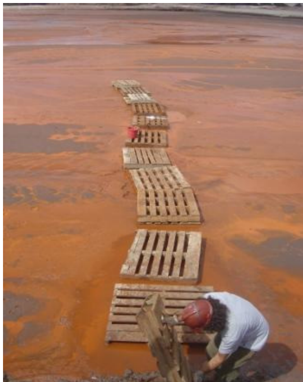
Figura 4.6 – Posicionamento dos estrados de madeira (“pallets”) utilizados na instalação da instrumentação
