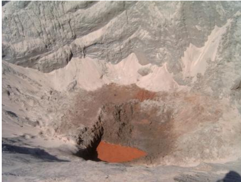
Figura 4.46 – Posição do nível d'água no depósito 15 dias após o término da construção do aterro teste (a 80cm de profundidade)
