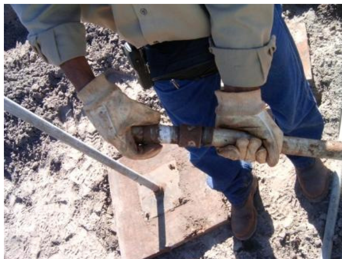
Figura 4.43 - Confirmação do posicionamento das placas de recalque e recuperação do Lev1
