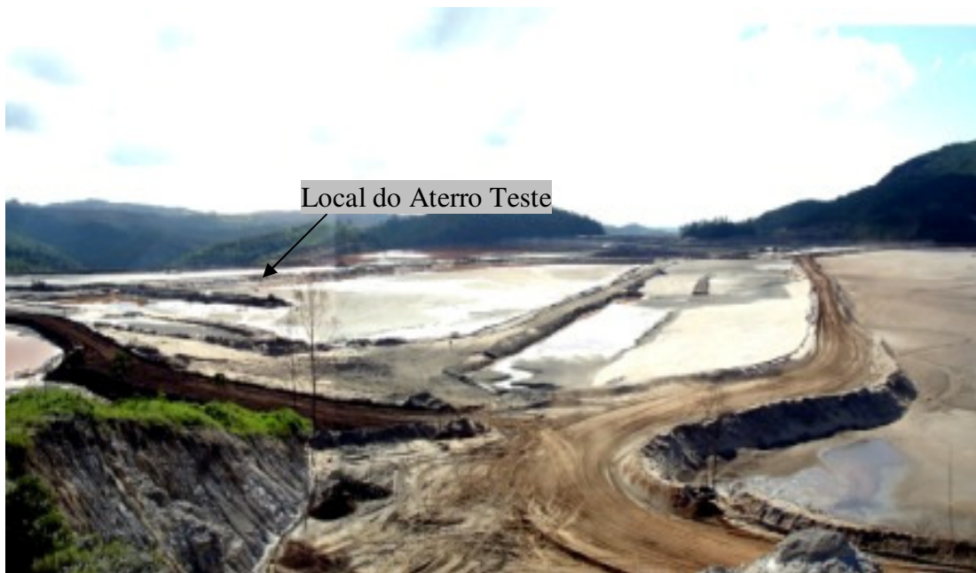
Figura 4.2 - Vista geral das estruturas existentes dentro da baía 2, antes da construção do aterro
