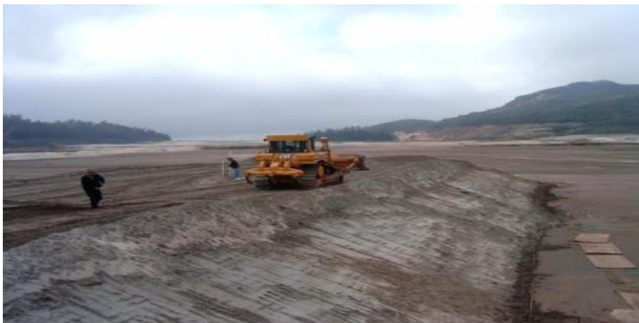
Figura 4.42- Situação do Aterro na ocasião do teste de vibração
