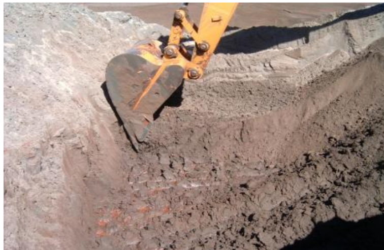
Figura 4.45 – Escavadeira próxima à superfície original do depósito (camada superficial de lama)
