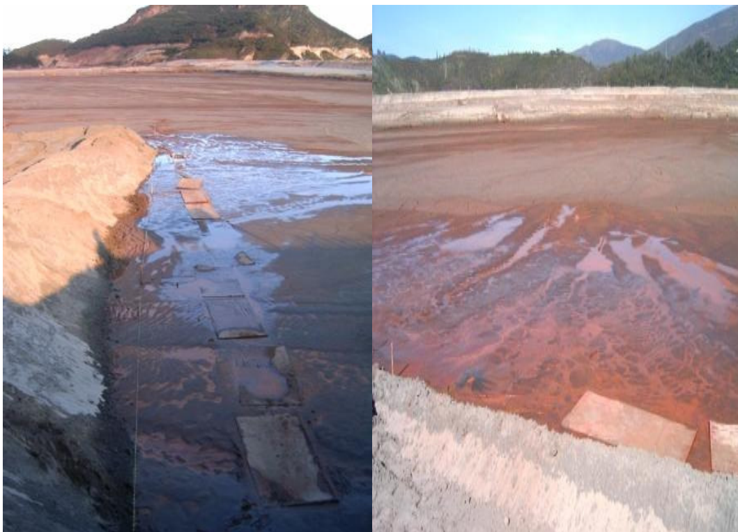
Figura 4.40 – Surgências d’água na superfície do terreno, no entorno do aterro
