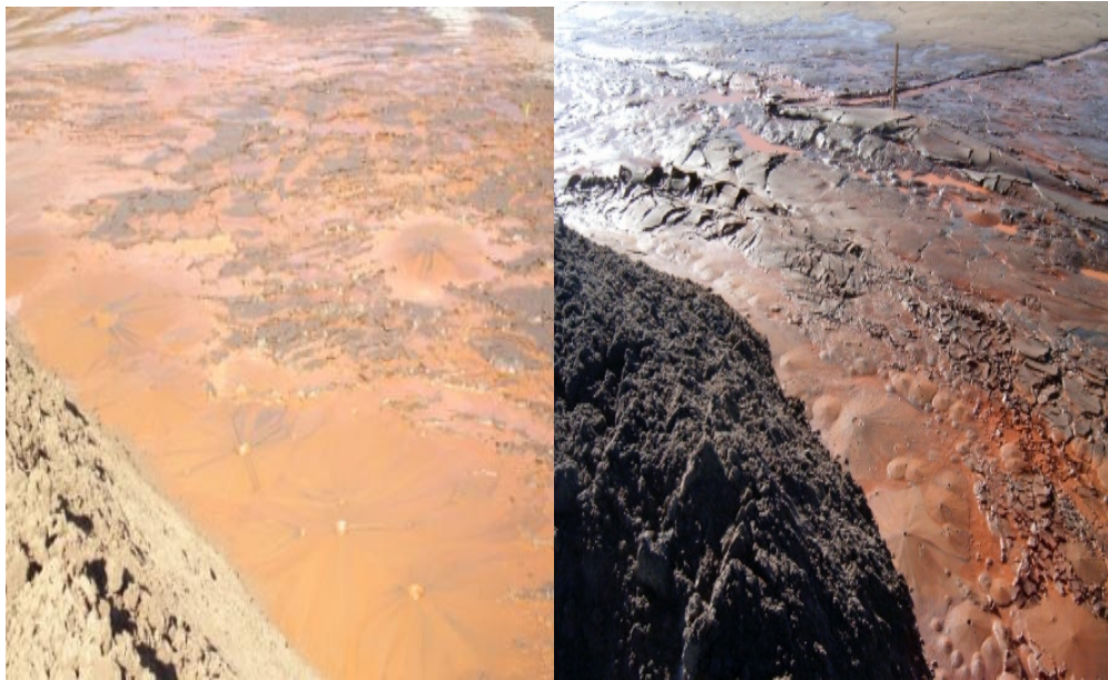
Figura 5.1 – Sand boils e trincas de alívio de poropressão - (a) construção do dique de reforço R2; (b) construção do aterro teste
