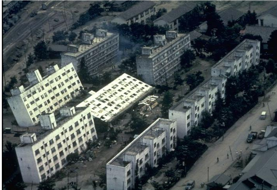
Figura 2.8 – Colapso de obras civis por causa de liquefação da fundação
