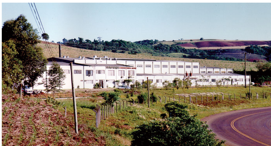
Figura 20 – Vista externa da Empresa Fonte: Empresa A
