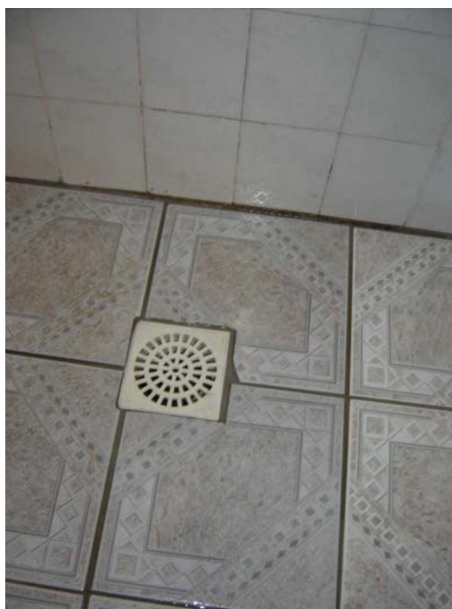
Figura 73 – Caixa sifonada em bom estado de conservação no conjunto habitacional Manoel Corralo
