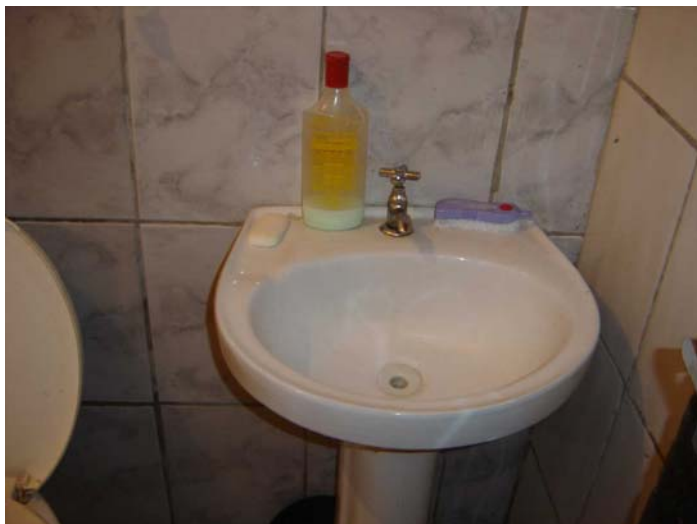
Figura 45 – Torneira do lavatório adequada no conjunto habitacional José Alexandre Zacchia
