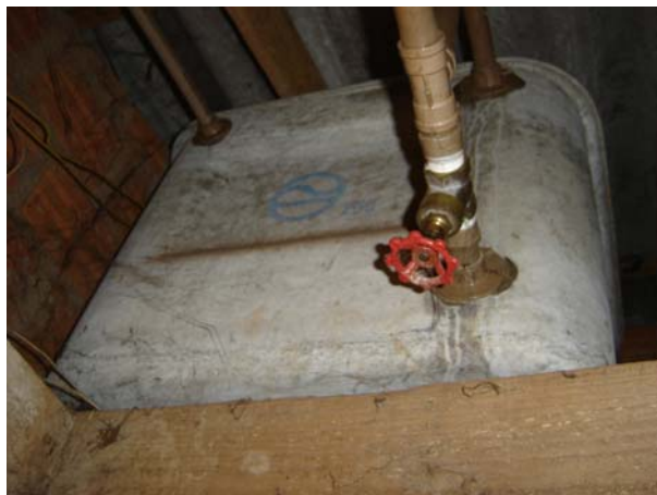
Figura 63 – Reservatório de fibrocimento localizado sobre o forro do banheiro no conjunto habitacional Jaboticabal/Alvorada
