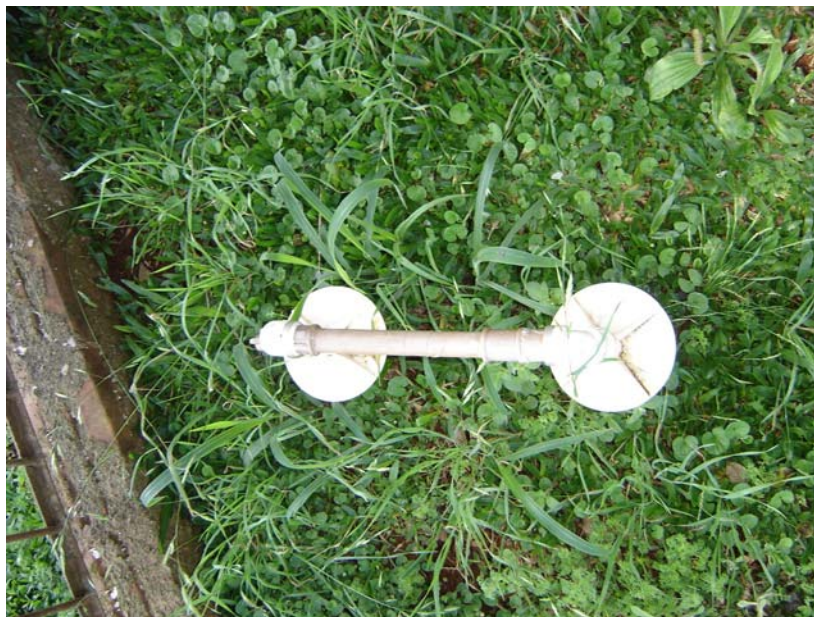
Figura 42 – Cavalete de hidrômetro em PVC no conjunto habitacional Luiz Secchi
