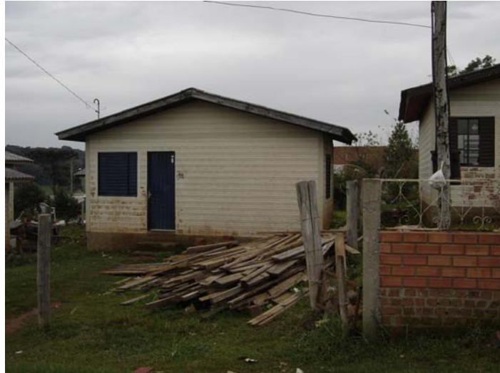
Figura 19 - Núcleo Habitacional Bom Jesus – Fachada da habitação (2005).
