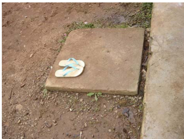
Figura 56 – Caixa de inspeção com tampa no conjunto habitacional José Alexandre Zacchia
