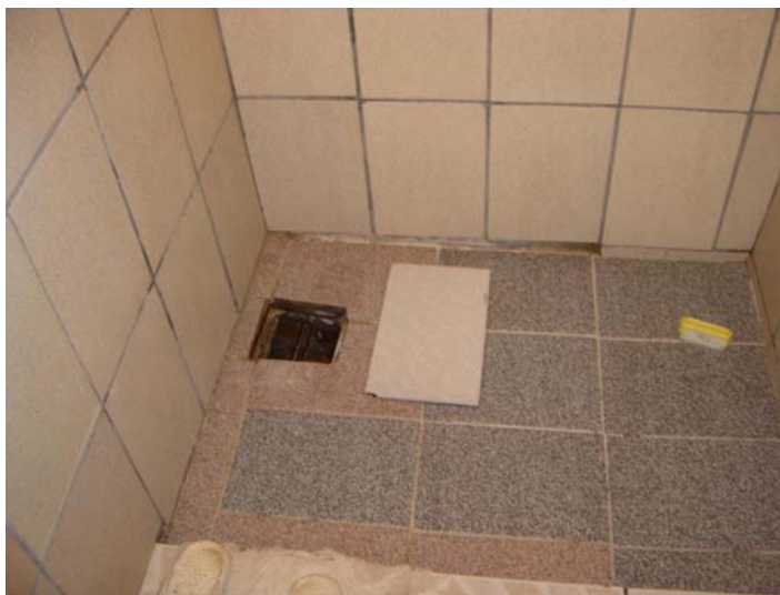
Figura 41 – Aspecto da caixa sifonada no conjunto Lucas Araújo
