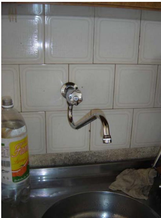
Figura 70 – Torneira adequada pia de cozinha no conjunto habitacional Jaboticabal/Alvorada
