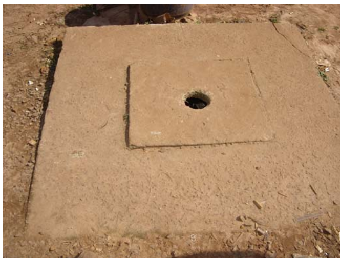
Figura 90: Sumidouro – conjunto habitacional Santa Marta
