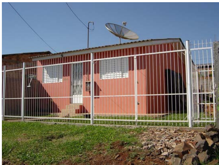
Figura 14 - Núcleo Habitacional Jaboticabal – onde visualiza-se que o usuário realizou modificações na fachada (2005).
