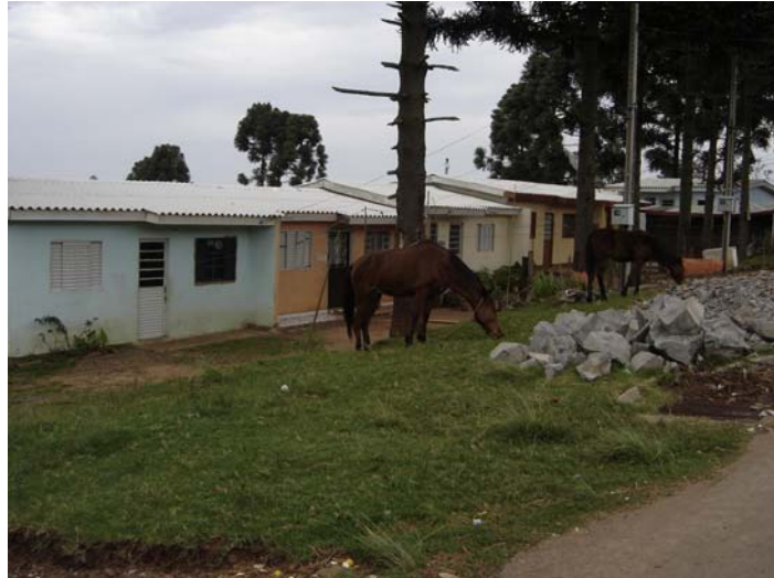
Figura 26 - Núcleo Habitacional Valinhos - vista do núcleo habitacional com a formação do “paredão”.
