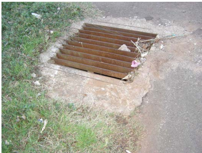
Figura 61 – Boca de lobo localizada no conjunto habitacional José Alexandre Zacchia
