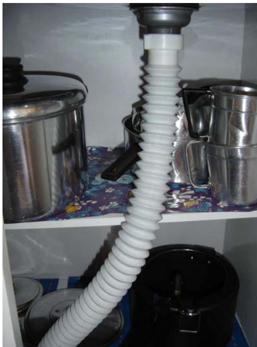
Figura 71 – Flexível no ramal da pia de cozinha encontrado no conjunto habitacional Manoel Corralo
