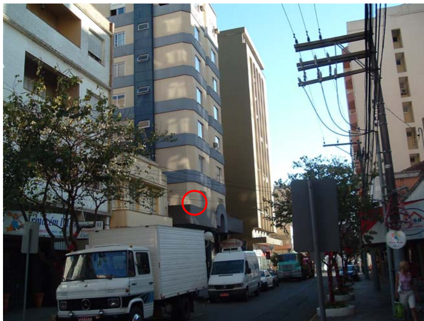
Figura 39 – Ponto 2: local da montagem do equipamento
