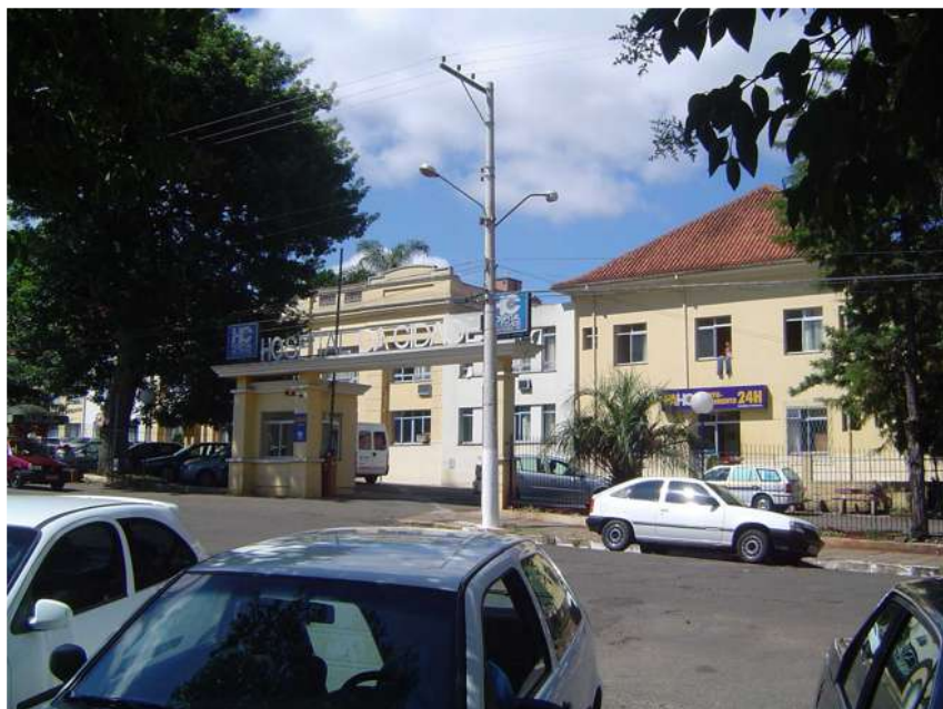
Figura 88 – “Hospital da Cidade” no entorno da praça
