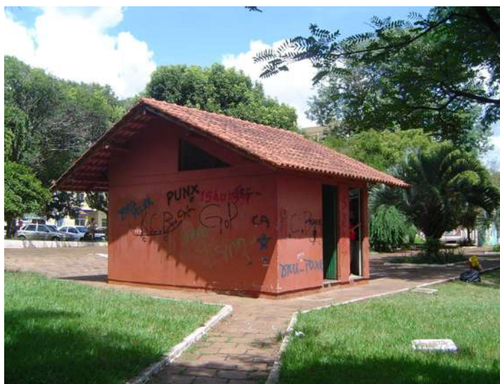
Figura 105 – Banheiro da Praça Antonino Xavier semelhante ao da Praça Tamandaré
