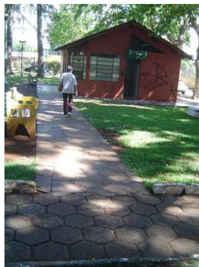
Figura 67 – Diferenças de piso dos caminhos da praça e em volta do banheiro
