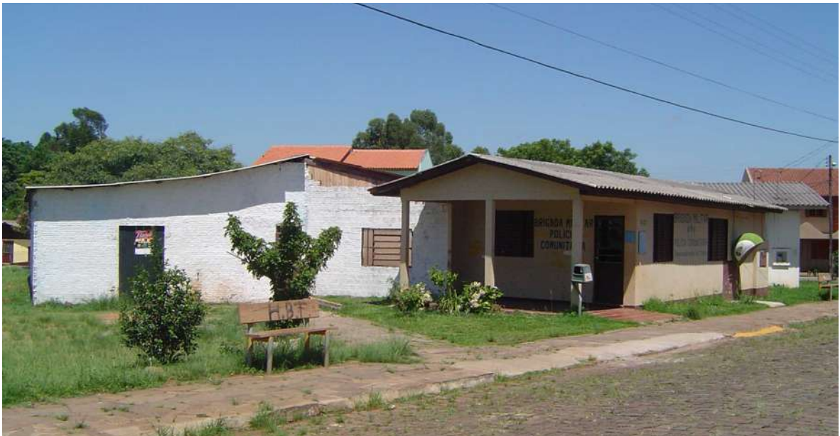
Figura 126 – Galpão à esquerda, posto policial à direita e ambulatório ao fundo mais à direita: padrões construtivos diferentes convivendo lado a lado.
