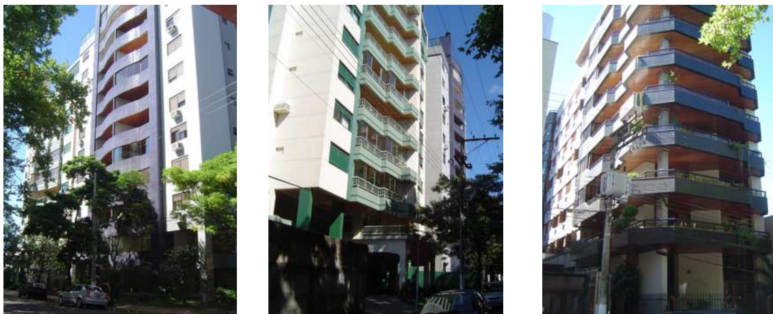
Figuras 51, 52 e 53 – Edifícios residenciais em altura (construções recentes)
