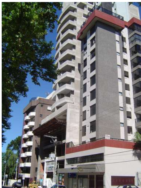
Figura 54 – Edifício alto em construção
