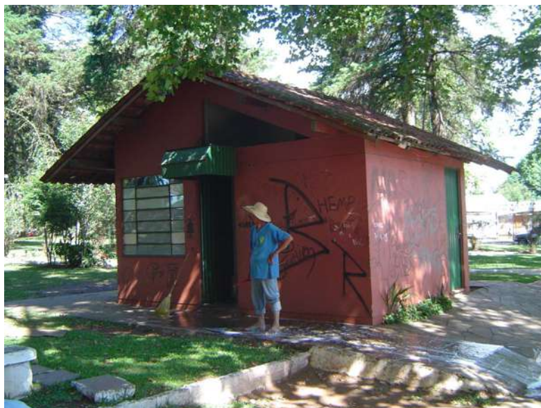
Figura 76 – Banheiro existente na Praça Tamandaré
