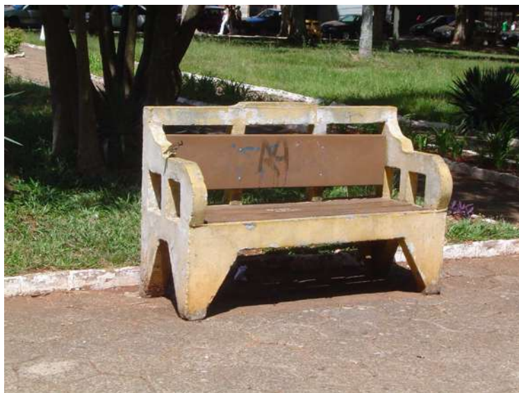
Figura 68 –Banco com aspecto “pesado” e manutenção ruim.
