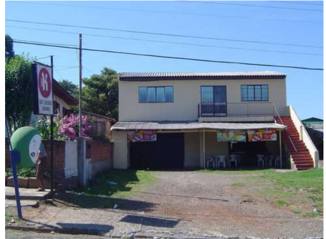
Figura 122 – Uso misto em construção de alvenaria
