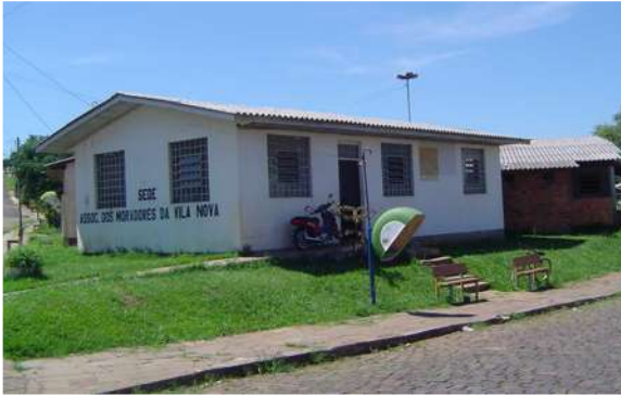
Figura 127 – Vista do ambulatório em bom estado de conservação
