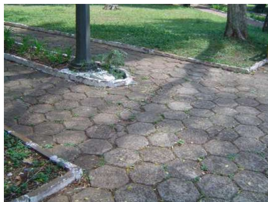
Figura 64 – Piso do caminho interno da praça e delimitação dos jardins
