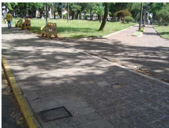
Figura 63 – Piso da calçada diferente do piso dos caminhos internos da praça
