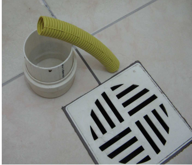
Figura 30: Tubo flexível para a coleta nos lavatórios.
