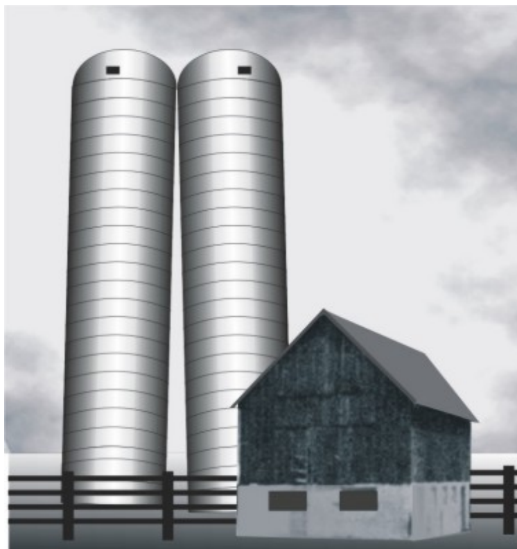
Figura 20: Silos que ilustram recalques diferenciais por sobreposição de tensões
