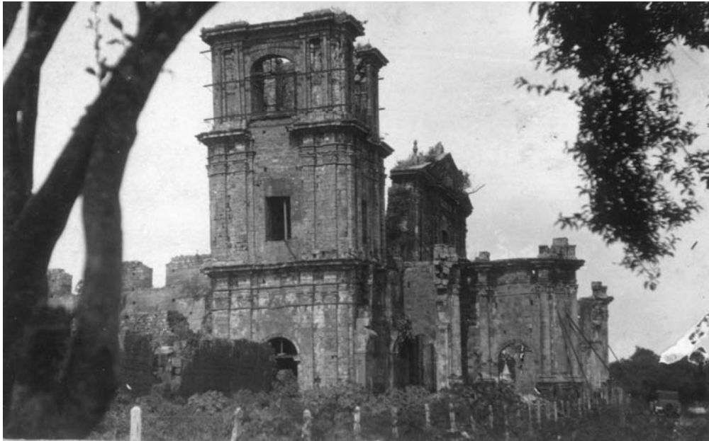
Figura 40: vista leste da torre após a estabilização e implantação do cercamento [1927 - 1938] (Arquivo Noronha Santos).
