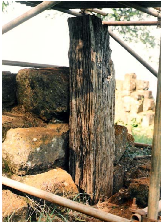
Figura 5: pilar de madeira utilizada nas estruturas autônomas
