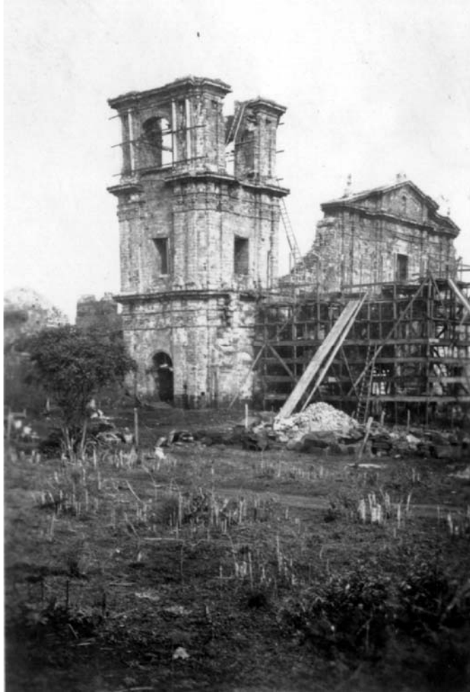
Figura 55: vista leste do pórtico com andaimes (Arquivo Noronha Santos, 1938)
