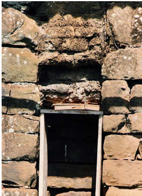
Figura 8: exemplo de adobe complementando paredes em pedra no colégio de São Miguel
