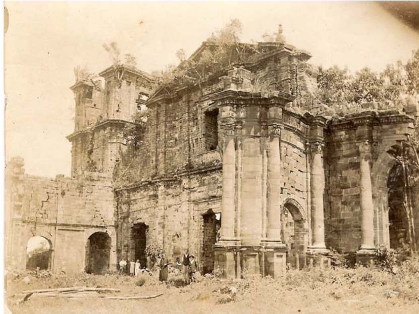
Figura 28: vista da frontaria da Igreja (Michael, anterior a 1925 Arquivo Escritório Técnico Missões – IPHAN)
