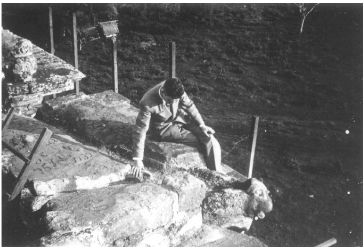
Figura 74: detalhe topo da torre, com a gárgula recolocada no ângulo noroeste da torre e a data de 25 de julho de 1939 (Arquivo Noronha Santos, 1939)
