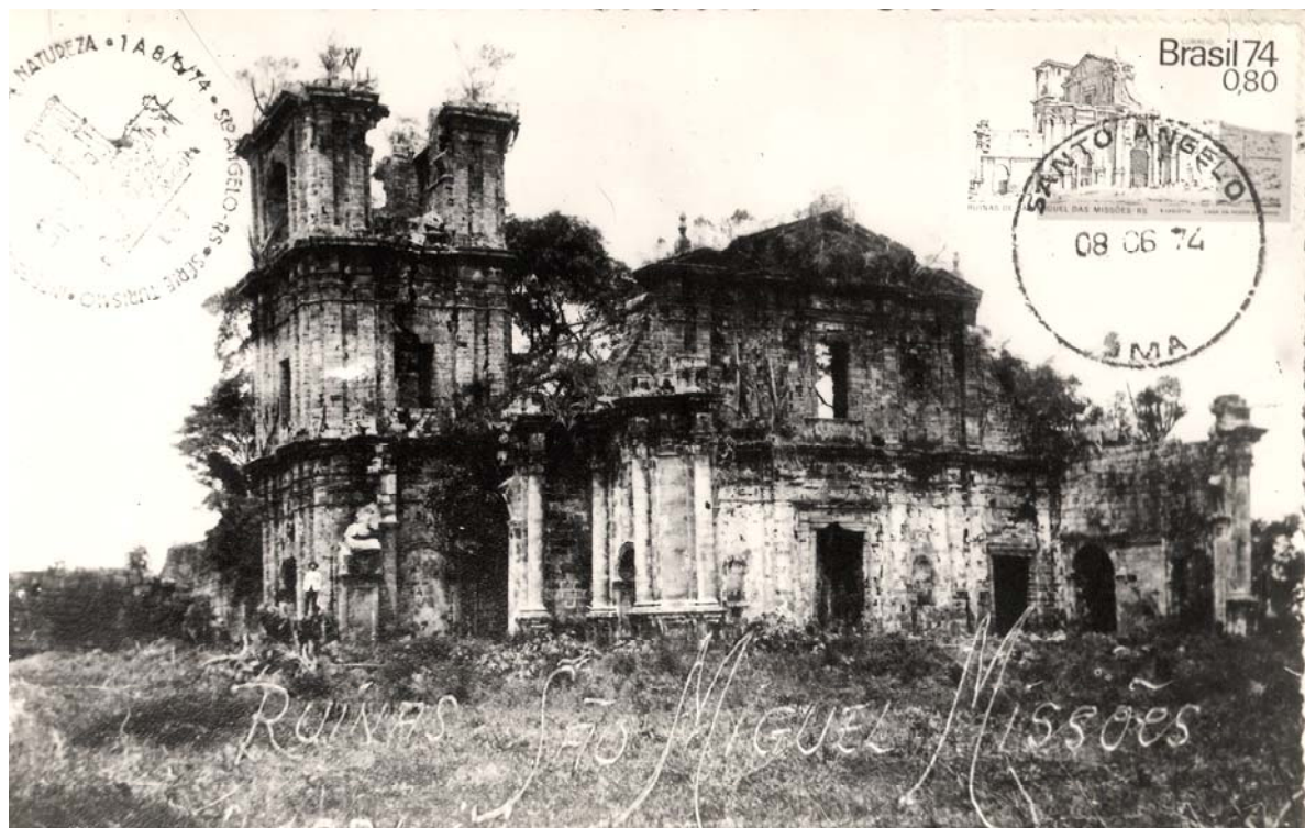
Figura 25: igreja de São Miguel em ruínas antes das intervenções do governo do Estado (Arquivo Escritório Técnico Missões – IPHAN)
