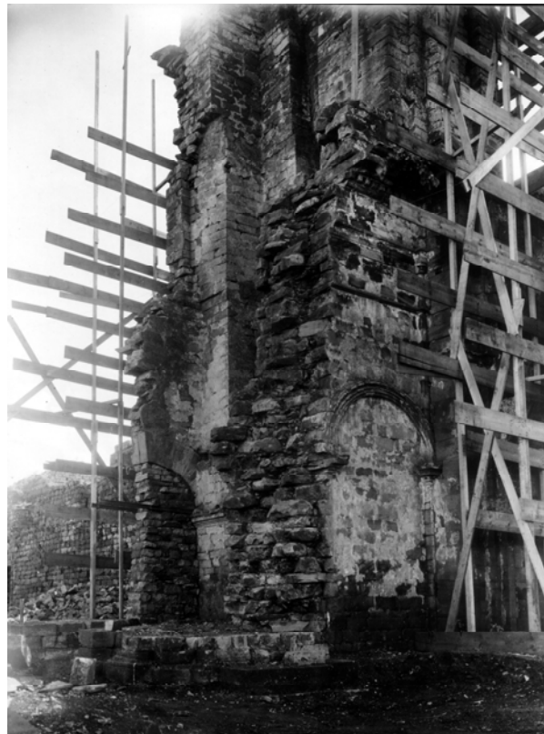
Figura 68: detalhe da torre desmontada, arco inferior sul preenchido para sustentação (Arquivo Noronha Santos, 1938)
