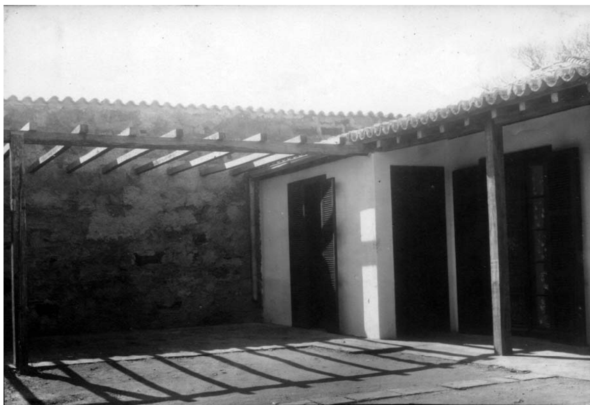
Figura 82: Casa do Zelador – concluída (Arquivo Noronha Santos, 1940)
