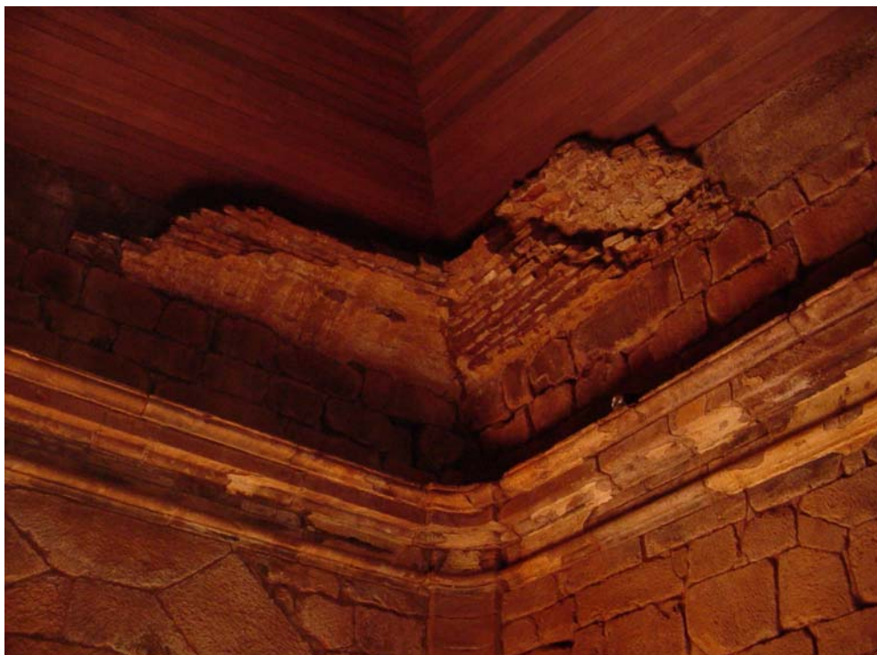
Figura 19: vestígios da abóbada construída com tijolos e cal
