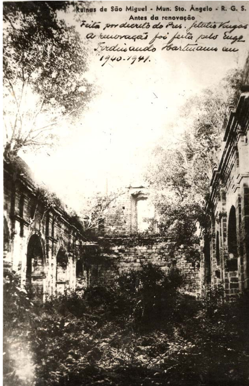
Figura 26: interior da nave central da Igreja de São Miguel antes das intervenções do governo do Estado (Arquivo Escritório Técnico Missões – IPHAN)
