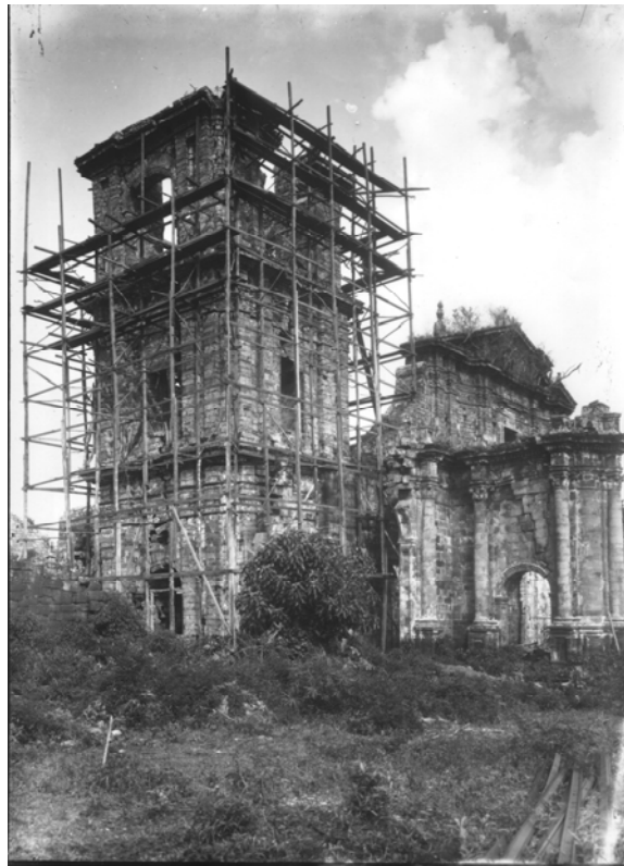
Figura 39: torre durante os trabalhos de estabilização (Arquivo Noronha Santos, 1925).
