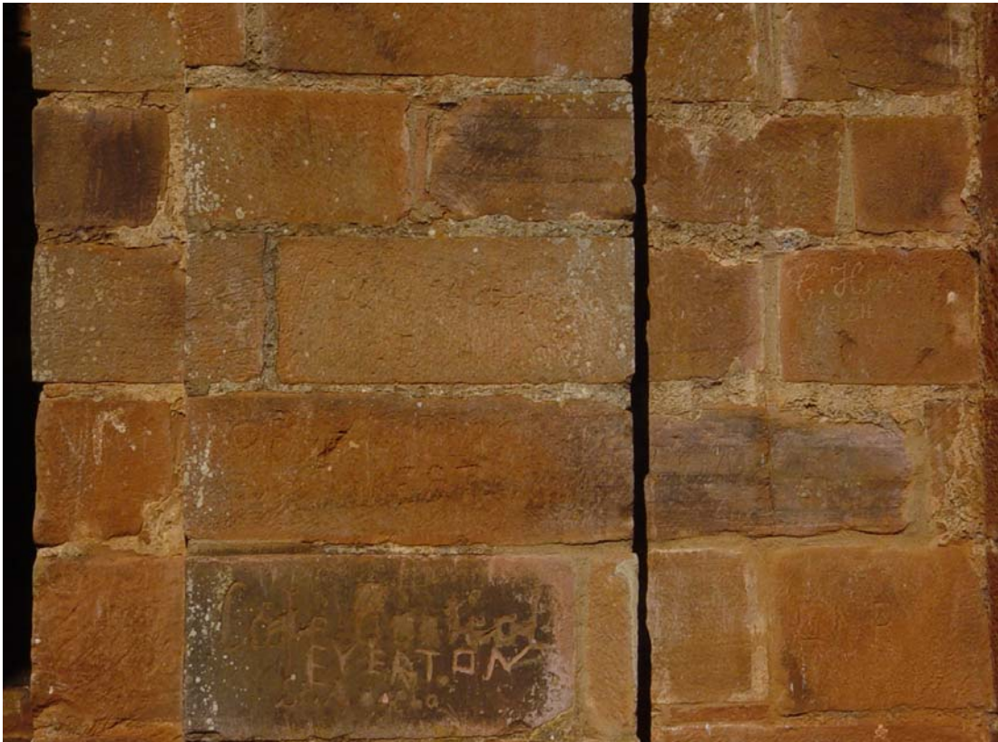
Figura 22: pedras aparelhadas utilizadas na construção dos pilares da arcada do lado do evangelho da Igreja
