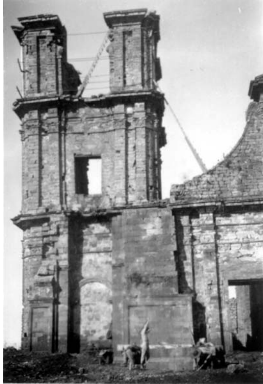
Figura 57: vista da fachada frontal, lado leste sem o pórtico (Arquivo Noronha Santos, 1938)
