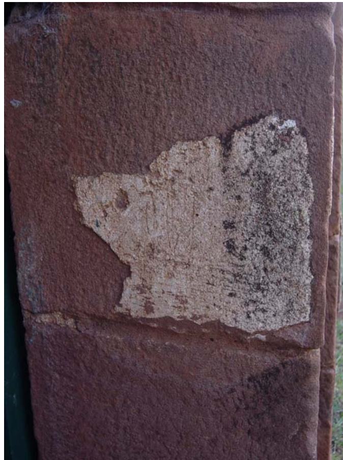
Figura 9: fragmento de reboco utilizando tabatinga e cal feita de caracóis
