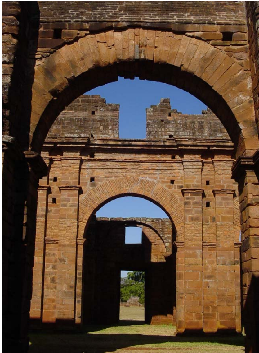
Figura 20: em primeiro plano se vê o arco original em pedra com parede de tijolos sobre ele, em segundo plano arco refeito em tijolos
