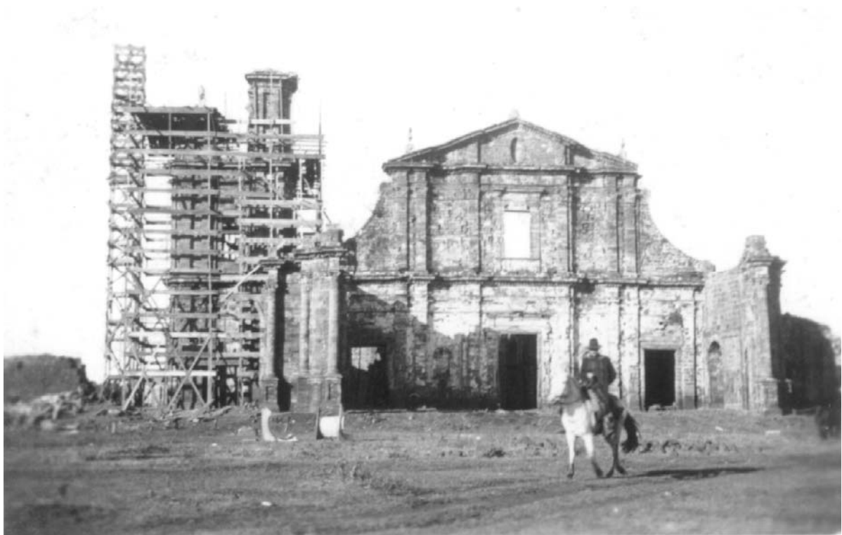
Figura 72: recomposição da torre (Arquivo Noronha Santos, 1939)
