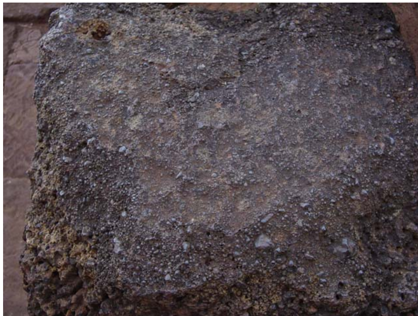
Figura 7: pedra de itacuru utilizada na construção das paredes do colégio, oficinas e outras estruturas complementares.
