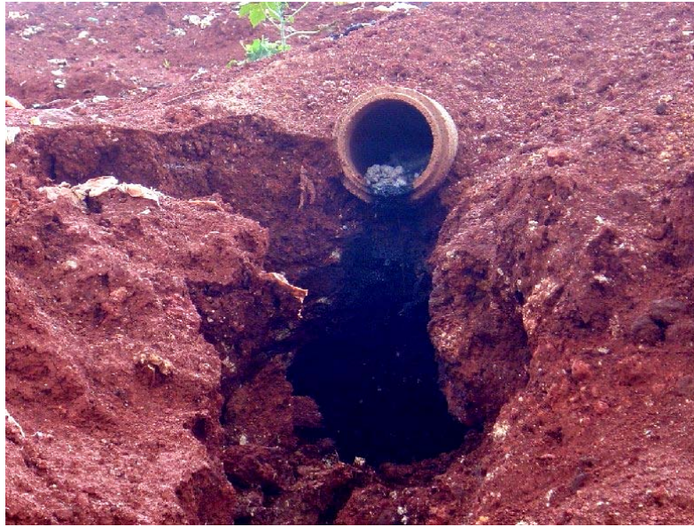
Figura 3.17: Coleta do lixiviado na saída da massa de resíduos
