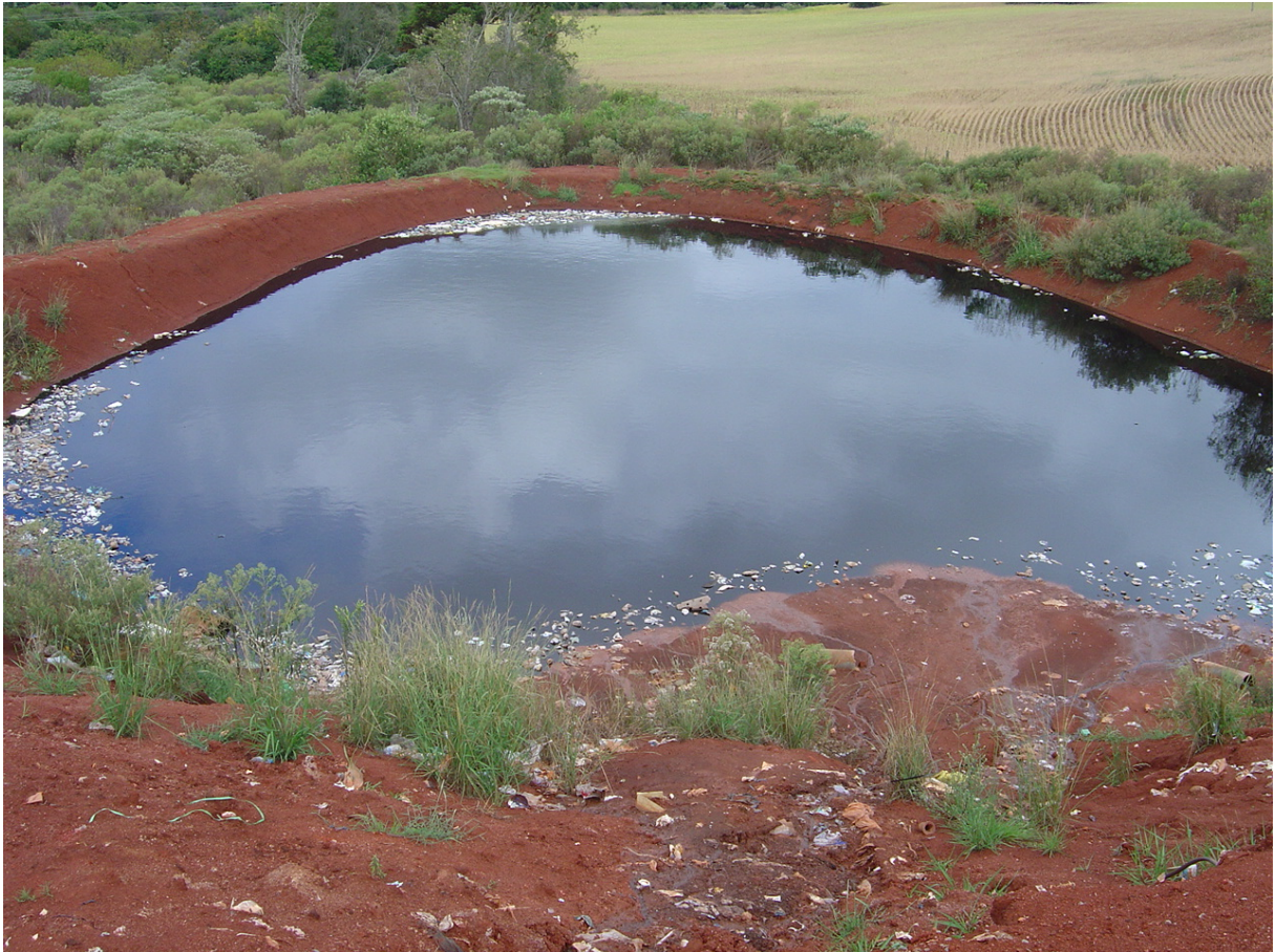
Figura 3.13 – Lagoa de estabilização da célula de resíduos em operação do aterro
