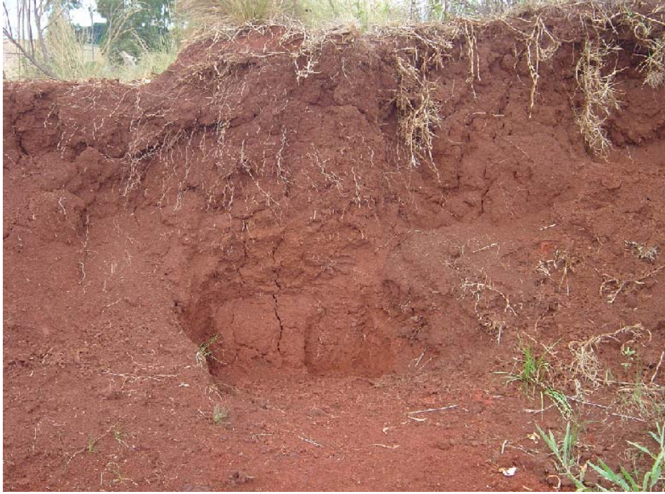
Figura 3.21 - Local da retirada de amostra de solo indeformada da área de aterro
