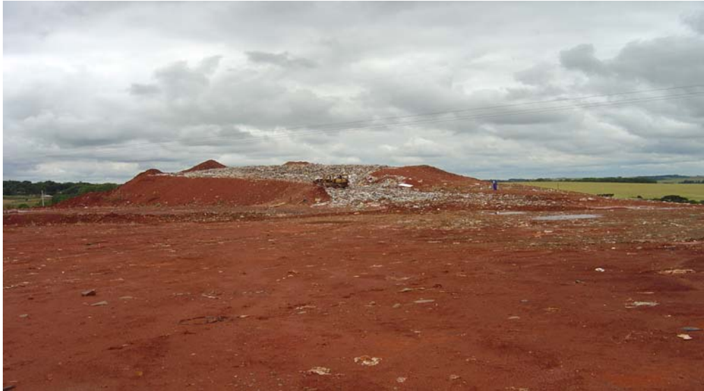
Figura 3.3 - Vista da célula do aterro controlado em operação
