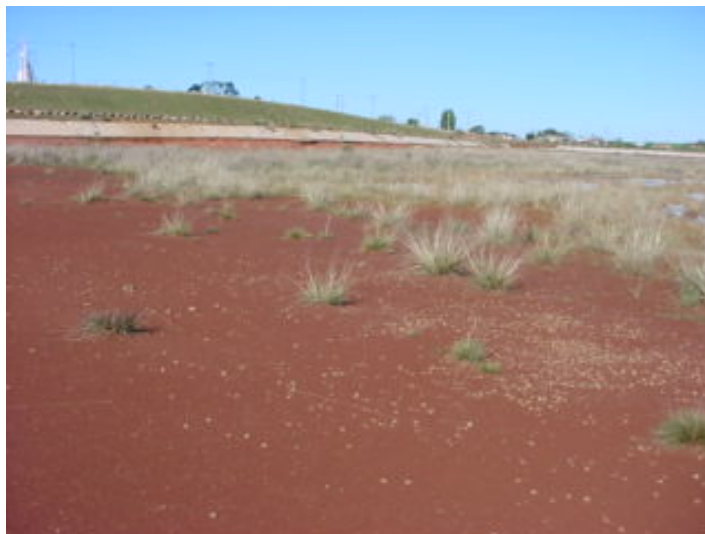
Figura 3.10 – Área de aterro da Lagoa Anaeróbia.
