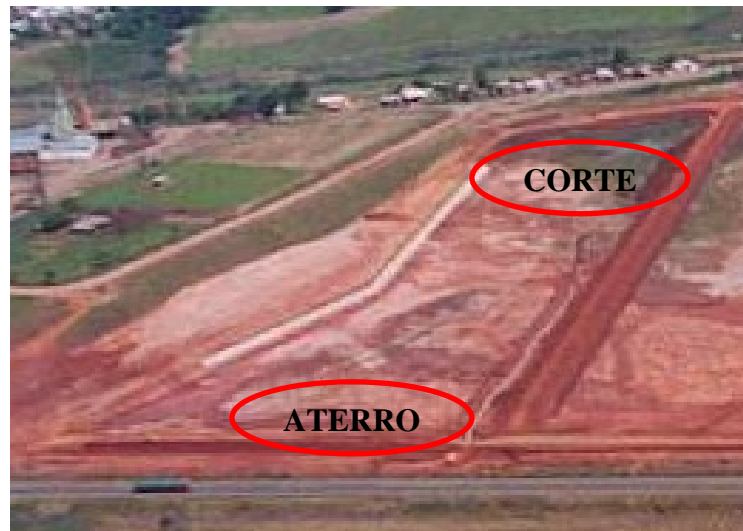
Figura 3.8 – Vista da Lagoa Anaeróbia.
