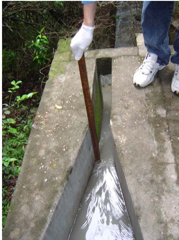
Figura 3.28 – Medição da Vazão na calha Parshal.
