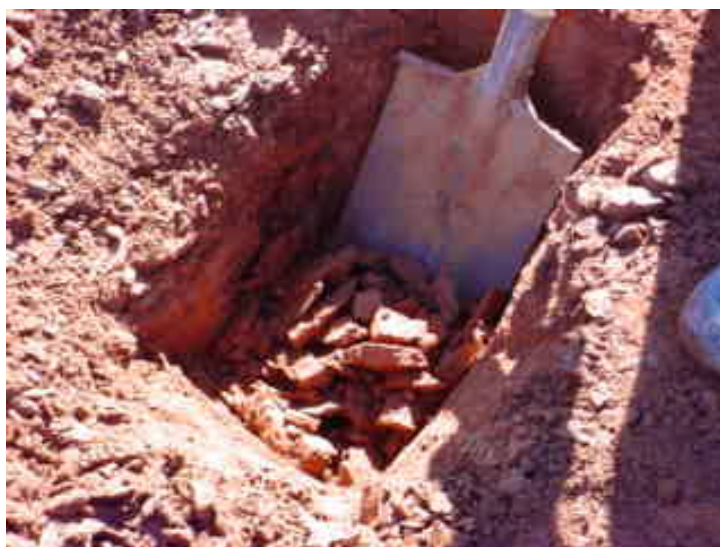
Figura 3.17 – Solo da área de aterro.
