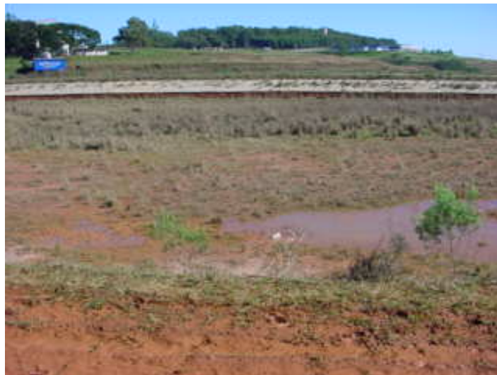
Figura 3.9– Área de corte da Lagoa Anaeróbia
