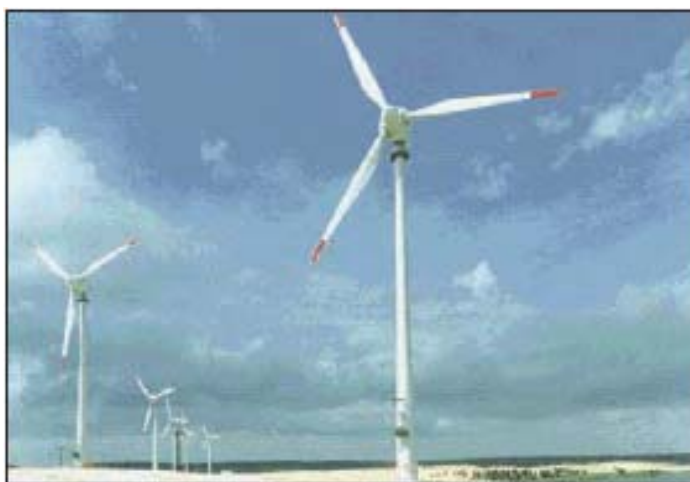
Figura 22: usina eólico-elétrica de Prainha, Município de Aquirás, Ceará (CENTRO BRASILEIRO DE ENERGIA EÓLICA, 2003)
