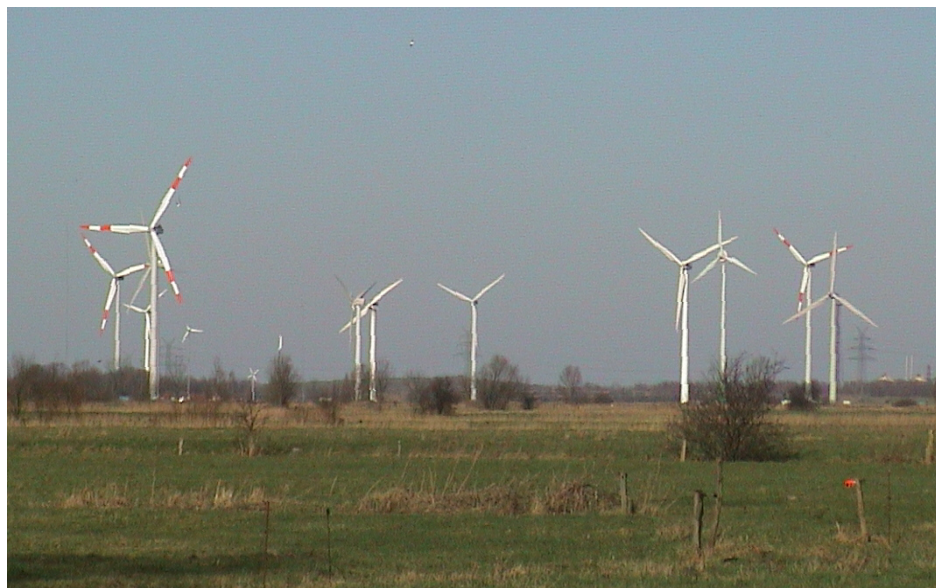
Figura 02: campo de teste do DEWI, em Wilhelmshaven, Alemanha (2004)
