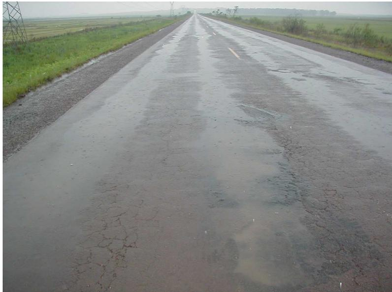
Figura 3: Afundamento em trilha de roda (ATR).
