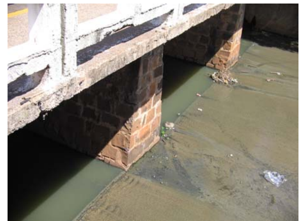
Figura 25: Outra vista da ponte da Avenida Brasil sobre o Rio Passo Fundo.
