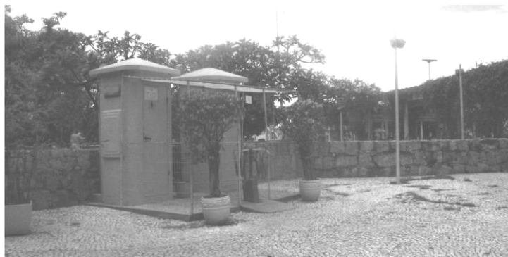
Fig. L61 Sanitários junto ao muro da área de estar.
