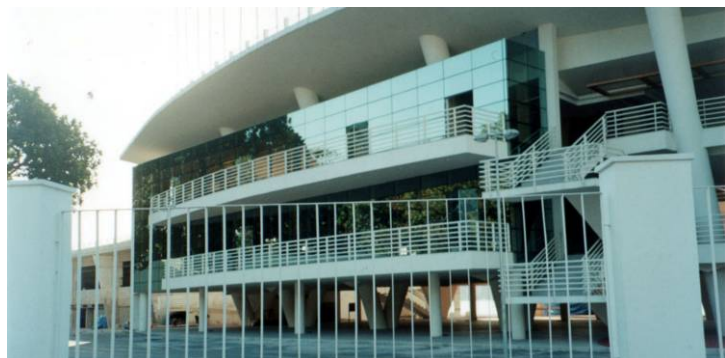
Fig. L23 Empreendimento em construção no interior Estádio de Remo da Lagoa, 2008.
