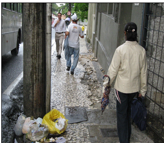
Figura 94 - Rua Chile: Calçada em Frente à Fundação Gregório de Matos (FGM) Fotografia: Francisco Lacerda Brito, ago./2007.
