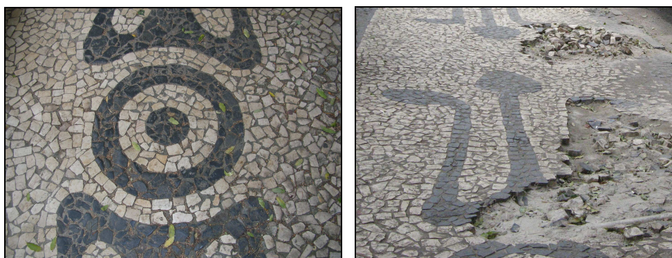
Figura 101 – Corredor da Vitória, entorno da Rua da Graça – Detalhes das calçadas Fotografia: Francisco Lacerda Brito, ago./2007.
