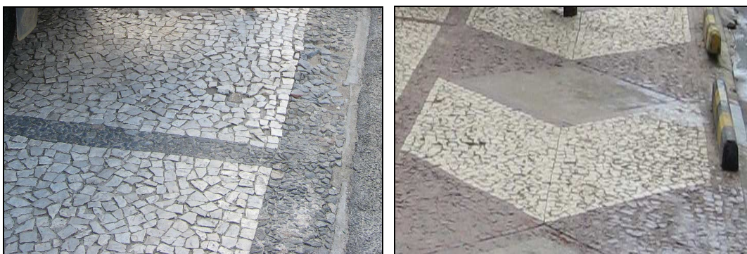
Figura 95 – Novo centro, Av. Tancredo Neves, detalhes das calçadas Fotografia: Francisco Lacerda Brito, fev./2007.
