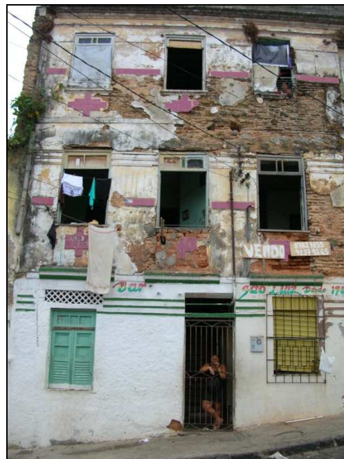
Figura 25 - Salvador: Região Central - Ladeira da Preguiça – Edificações antigas Fotografia: Francisco Lacerda Brito, ago./2007.
