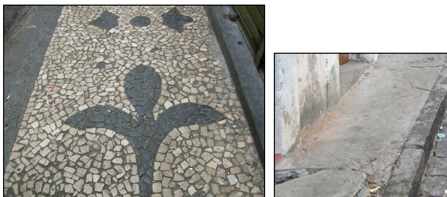
Figuras 89 e 90 - Detalhe das calçadas Rua Chile e Ladeira da Preguiça Fotografias: Francisco Lacerda Brito, ago./2007.
