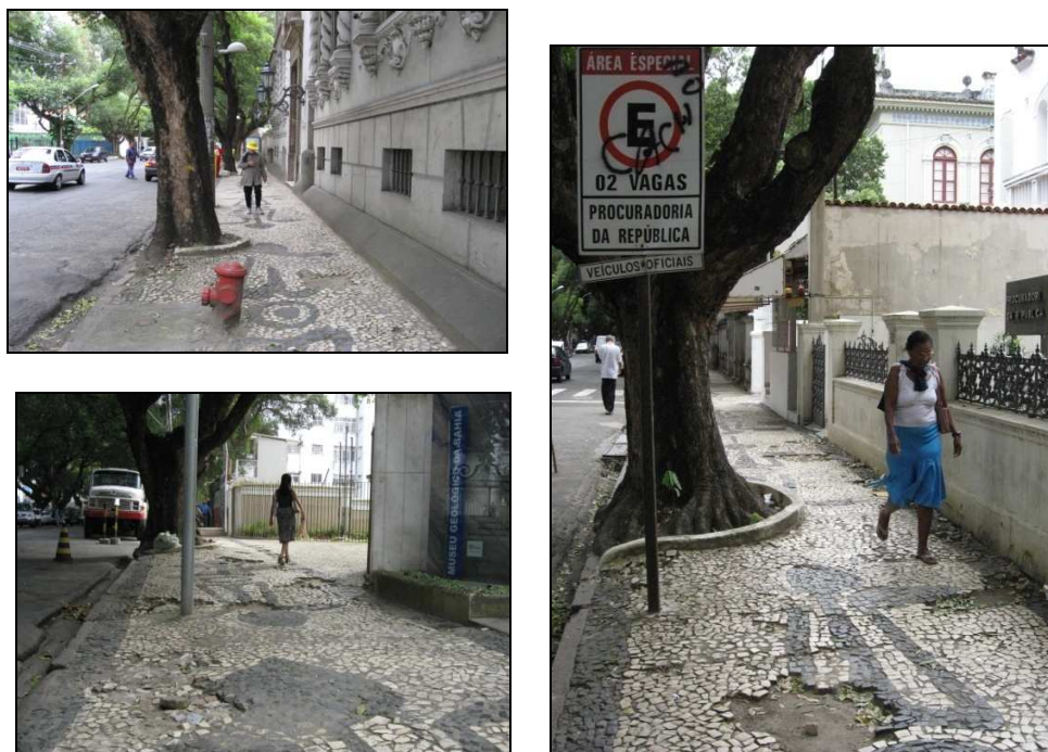
Figura 76 - Salvador: Corredor da Vitória – Detalhe4 do passeio local.
