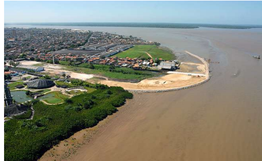
Início das obras do Portal da Amazônia em Belém, com o Mangal das Garças em primeiro plano.
