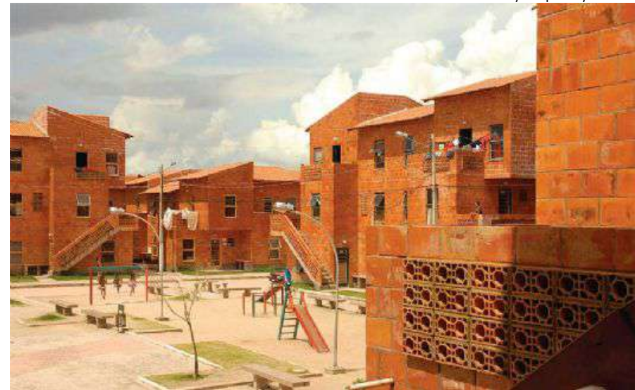
Conjunto habitacional da Vila da Barca, em Belém. Fonte: Revista AU, n 170, maio de 2008.
