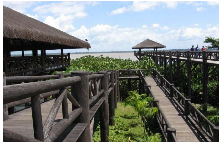
Mangal das Garças, Belém – Memorial da Navegação e Mirante. Fonte: o autor, 2007.
