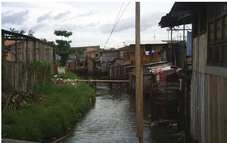
Áreas de ocupação irregular nas proximidades da UFPA, em Belém. Fonte: Ponte, 2006
