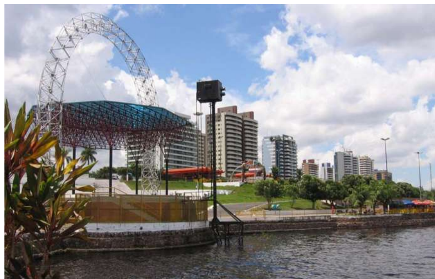
Trechos do Parque da Ponta negra, em Manaus. Fonte: o autor, 2007.
