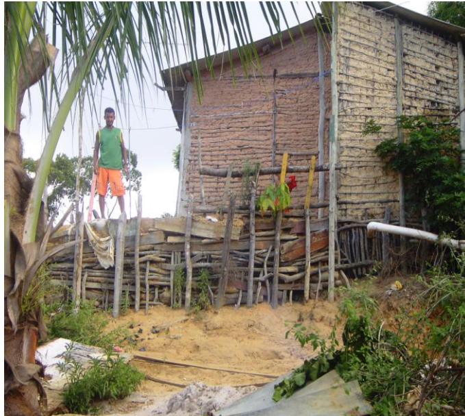
Foto 39 – Residências de Pau-a-Pique ou Barro Fonte: Ernesto Pablo Mata Machado – Maio 2007
