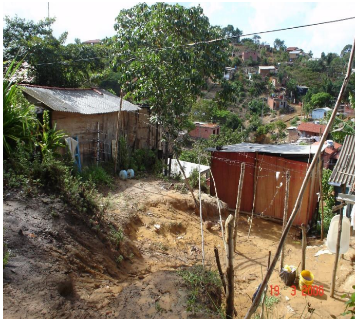
Foto 27: Casas de compensado e telha de amianto do loteamento Fonte: Ernesto Pablo Mata Machado – Maio 2007
