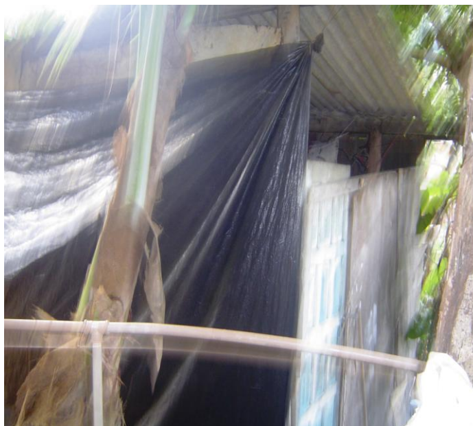
Fotos 34: Residência com uso de lonas plásticas Fonte: Ernesto Pablo Mata Machado – Maio 2007
