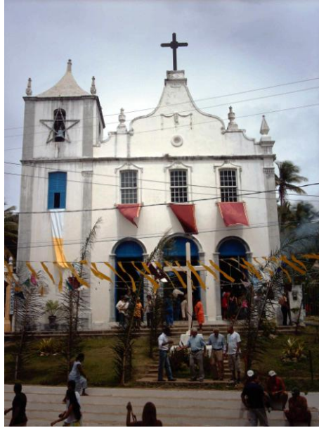
Foto 4: Igreja Nossa Senhora da Luz – Morro de São Paulo Autor: Ernesto Pablo Mata Machado – Setembro de 2007
