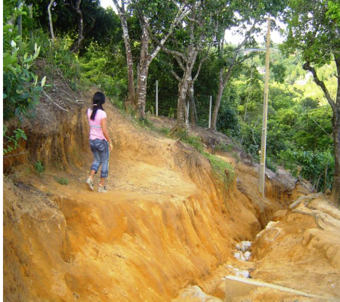
Foto 48: Processo erosivo dentro do loteamento Nossa Senhora da Luz Margem superior esquerda de descida à rua principal.
