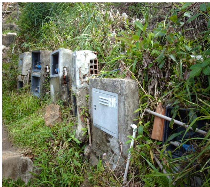
Foto 24: Marcadores de consumo de água das residências do loteamento Fonte: Ernesto Pablo Mata Machado – Maio 2007
